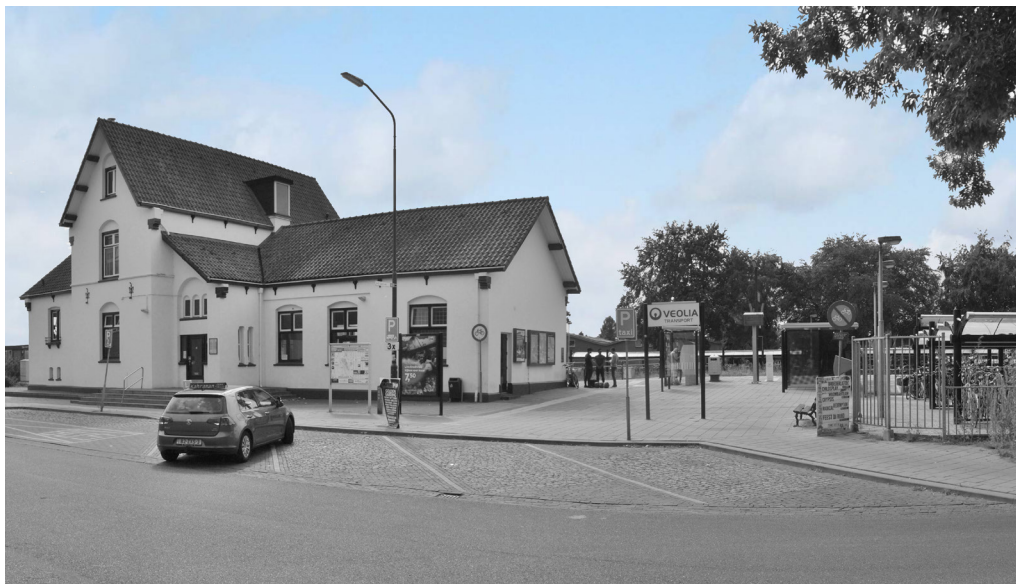
Huidige situatie station Cuijk
