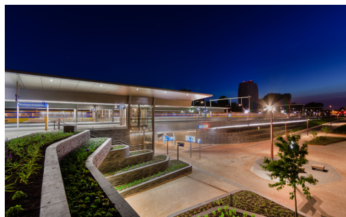
Nieuwbouw station en herinrichting stationsomgeving. Stakeholders: gemeente Groningen, NS en ProRail.
