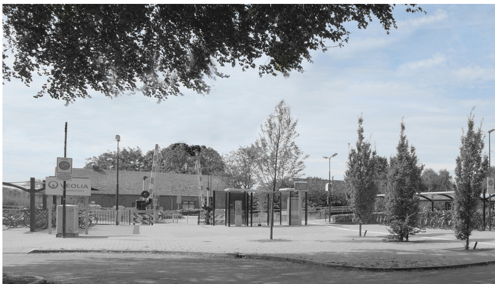
Huidige situatie station Vierlingsbeek
