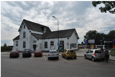
Station Cuijk: het gebouw staat leeg. Oriënteren en navigeren is lastig.
