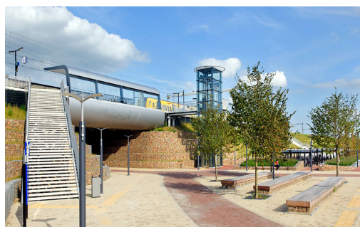
Nieuwbouw station, nieuwe onderdoorgang, fietsenstalling en herinrichting stationsomgeving. Stakeholders: gemeente Westervoort, NS en ProRail.
