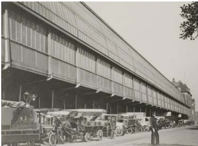
(afb. 35) zicht langs de gevel van het IJgebouw waar men laadt en lost / foto 1929 GAA
