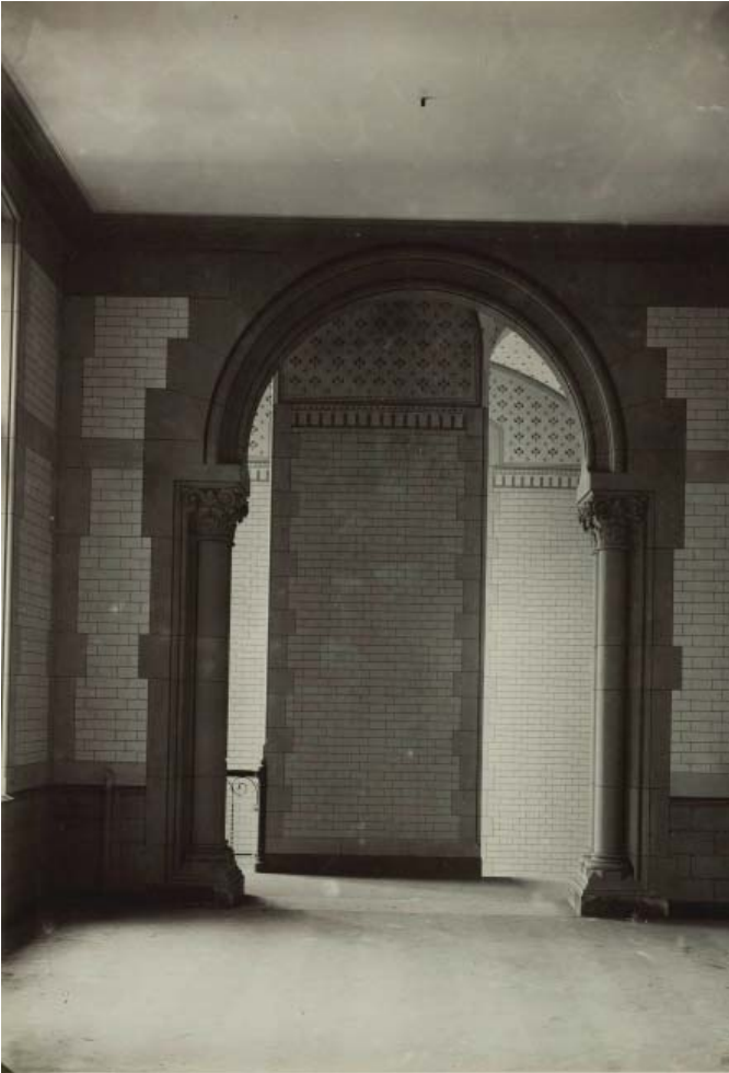
(afb. 110) de opgang vanuit de hal via de toren naar de gang van de tweede verdieping / foto 1889 SWM
