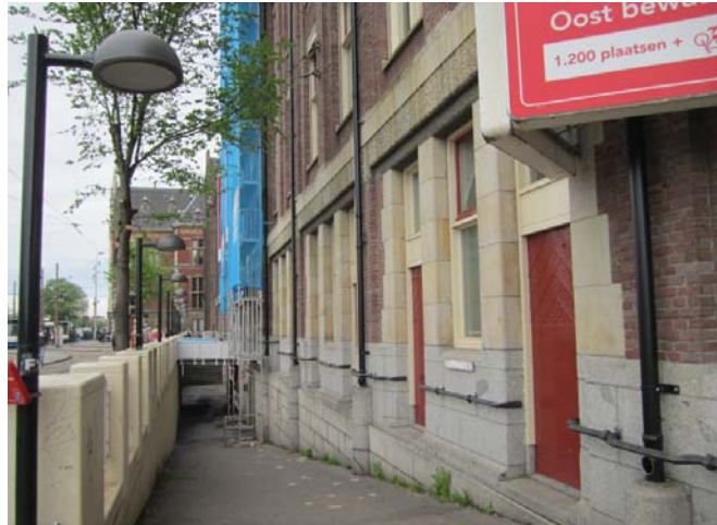
(afb. 172) de hellingbaan langs de voorgevel / foto 2012 TAK
