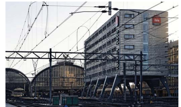
(afb. 82) uitbreiding van het Ibis hotel die afsteunt op het eerste en tweede perron / foto 2009 www.architectenweb.nl
