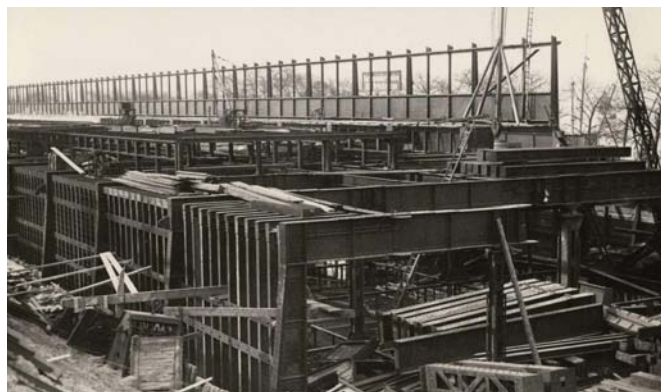
(afb. 135) aanleg van het IJgebouw / foto 1920 SFA
