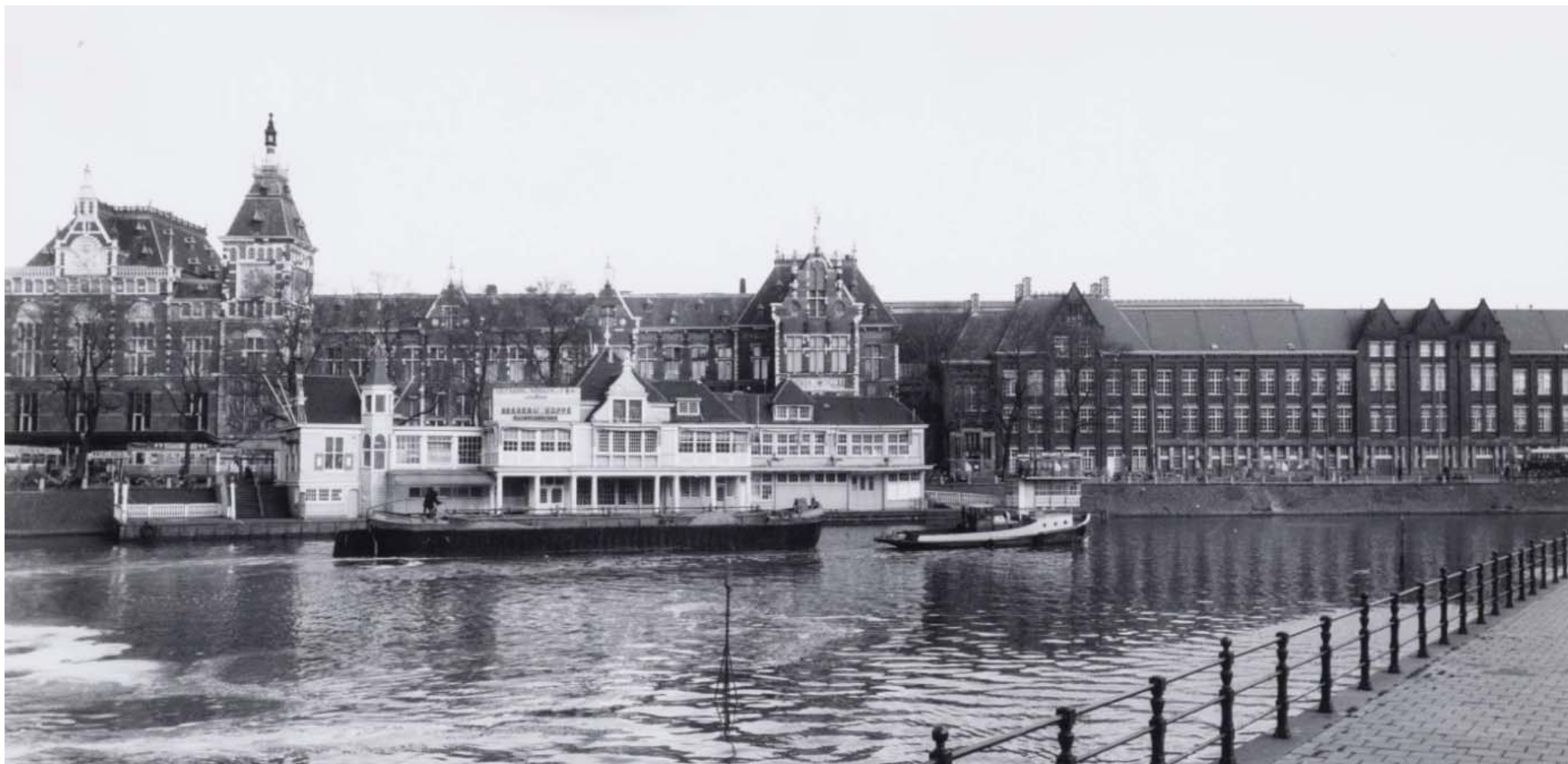
(afb. 143) zich op de subtiële aansluiting van gebouw De Oost op het hoofdgebouw op een foto uit 1971 met op de voorgrond het Noord-Zuid Hollandsch koffiehuis (ontworpen door architect J.H.W. Leliman) / foto 1971 GAA
