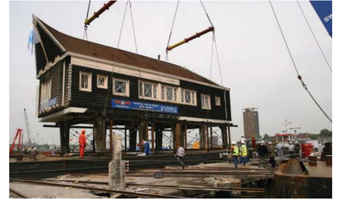
(afb. 40) foto van het scheepvaart kantoor uit 2004, dat nu het Naco-gebouwtje wordt genoemd, op een drijvend ponton in het IJ, met rechts op de voorgrond steiger 7 waar het gebouwtje gestaan heeft; het gebouwtje moest worden verplaatst in verband met de nieuwe plannen voor de zuidelijke IJ-oeveren. / foto 2004 GAA
