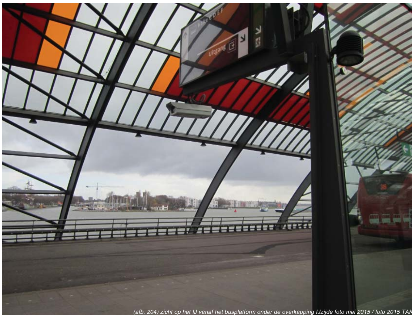
(afb. 204) zicht op het IJ vanaf het busplatform onder de overkapping IJzijde foto mei 2015 / foto 2015 TAK
