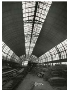
(afb. 133) foto's van de zuidkap tijdens de bouw, die veel grotere glasoppervlakken krijgt dan de noordkap / foto's 1924 SSP
