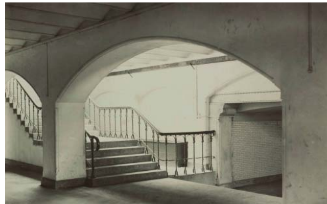
(afb. 125) zicht vanuit de ruimte onder het 1ste perron met links de opgang naar het 1ste perron en rechts de toegang tot de tunnel / foto 1889 SWM
