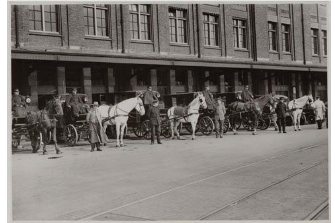
(afb. 144) foto van de wachtende postkoetsen onder de luifel aan de voorgevel van gebouw De Oost / foto 1932 GAA
