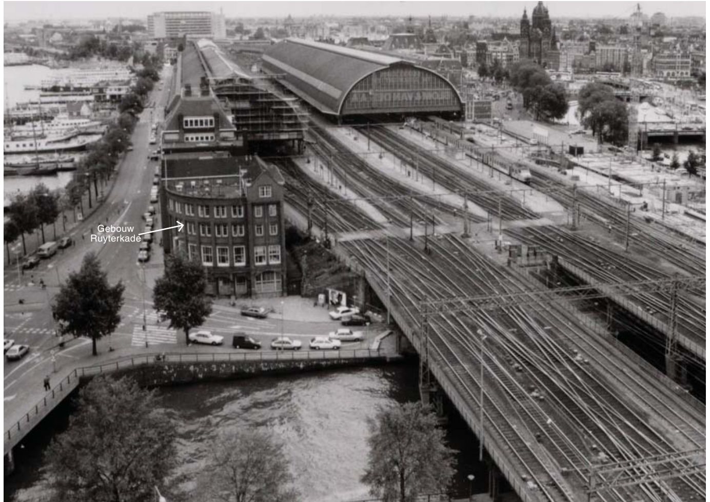
(afb. 79) zicht vanaf het Havenbouw op de noordwesthoek van het middeneiland met de situatie vóór de uitvoering van 'Amsterdam Centraal, spoor 10-15' foto 1991 GAA
