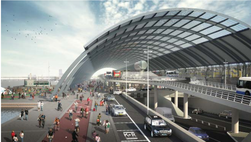
(afb. 192) impressie van de De Ruyterkade na voltooiing van de geplande werkzaamheden, met de nieuwe overkapping en het busplatform (IJsei) met daaronder de IJhal, die tezamen een gestapeld plein vormen / beeld 2015 Gemeente Amsterdam
