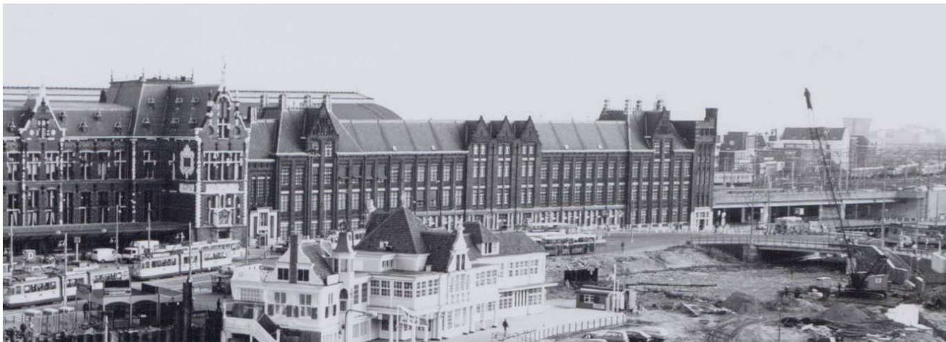
(afb. 36) de voorgevel van het Cuypersgebouw met rechts gebouw De Oost / foto 1981 RCE
