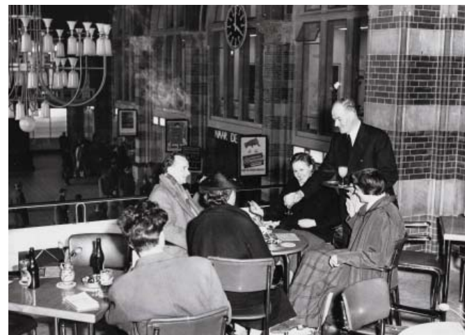
(afb. 158) ter plaatse van de oostelijke en westelijke arcade maakte Schelling balkons; foto genomen vanaf het oostelijke balkon, grenzend aan de zgn. stille wachtkamer voor de 1ste klas reizigers / foto 1956 GAA
