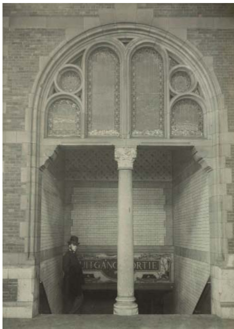
(afb. 124) vanaf het 1ste perron kan men direct uitkomen bij de uitgang van het stationsgebouw via de sortie-trappen, zo genoemd omdat zowel in het Nederlands als in het Frans is aangeduid dat zich hier de uitgang bevindt / foto 1889 SWM
