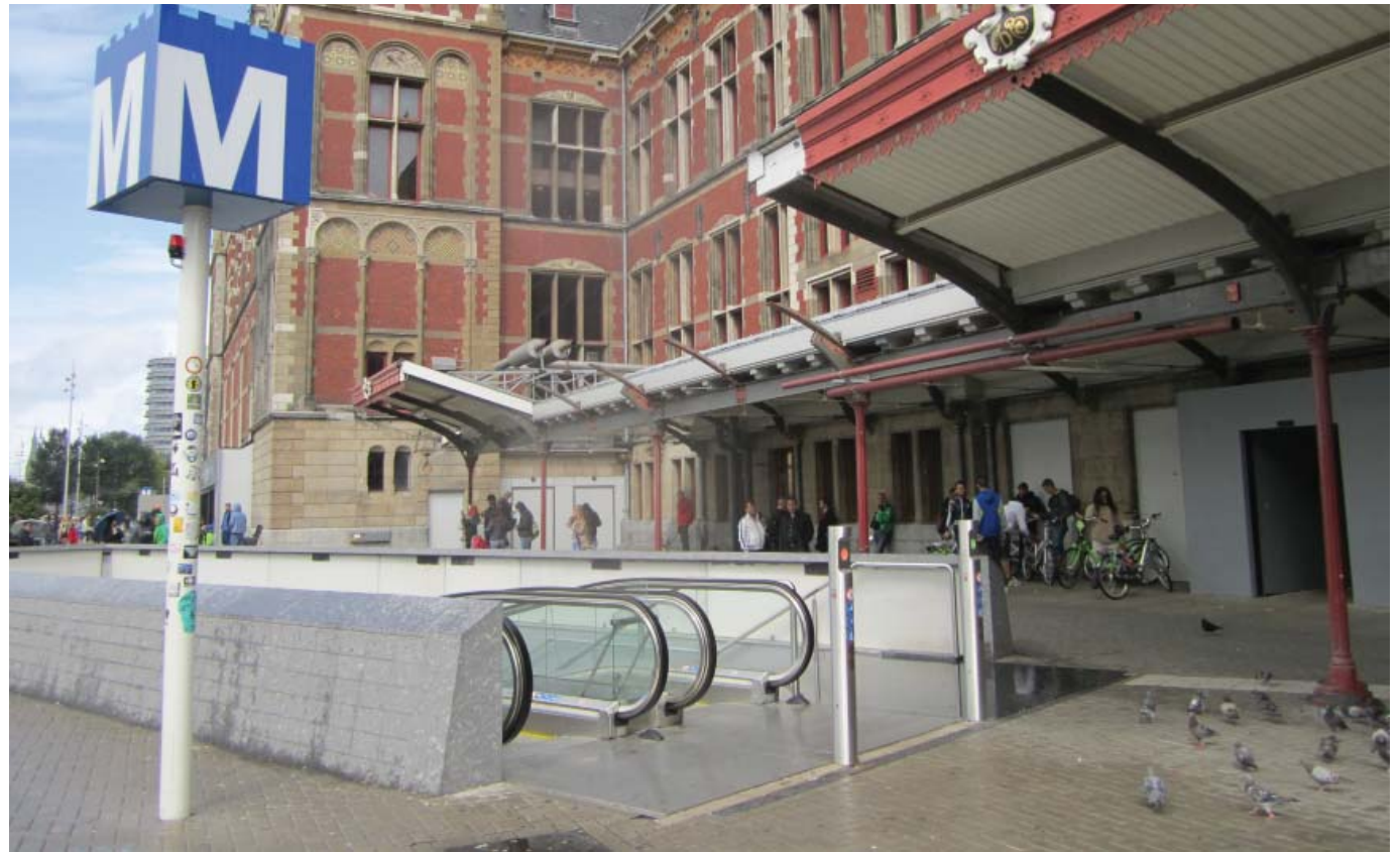
(afb. 200) de reeds uitgevoerde nieuwe opgangen naar het metrostation / foto 2014 TAK
