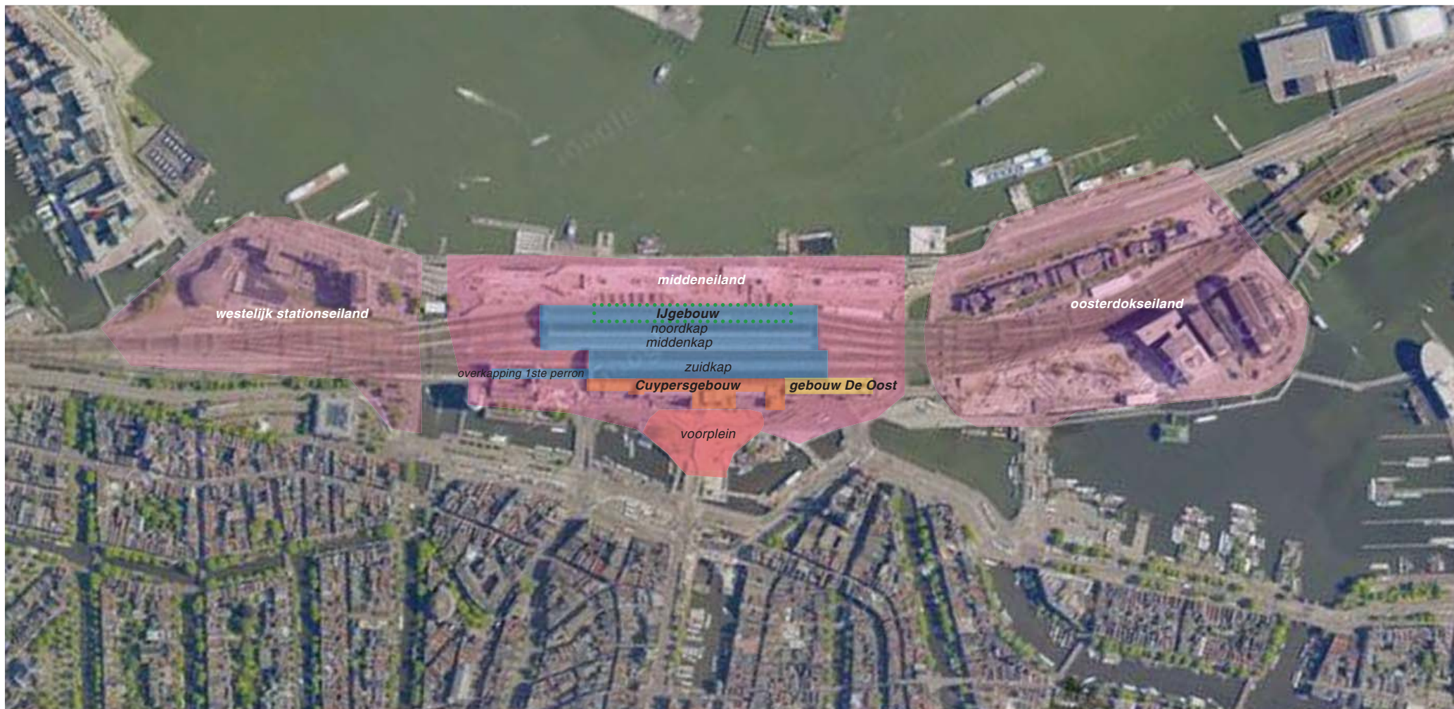
(afb. 5) overzicht van het stationscomplex / foto 2013 Google Maps
