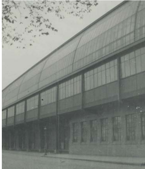
(afb. 137) de gevel verspringt naar achteren ter plaatse van de loodsen (links onder) en naar voren ter plaatse van de kantoren (rechts onder); de uitstekende erker voor het 6de perron vormt een afdak / foto 1924 SWM
