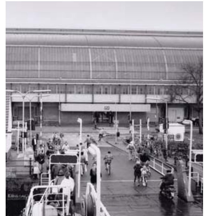
(afb. 170) de toegang tot de westtunnel / foto 1994 GAA
