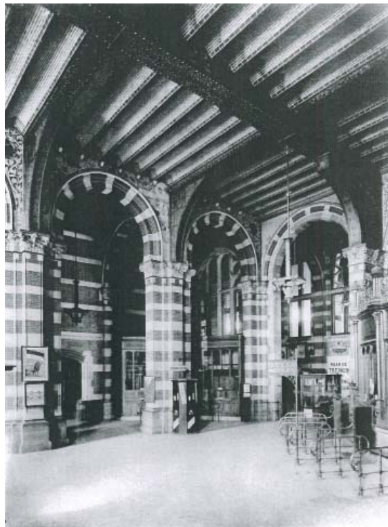
(afb. 118) de moeder- en kindbalken constructie en bakstenen boogconstructies bepalen het aanzicht van de hal / foto 1889 SWM
