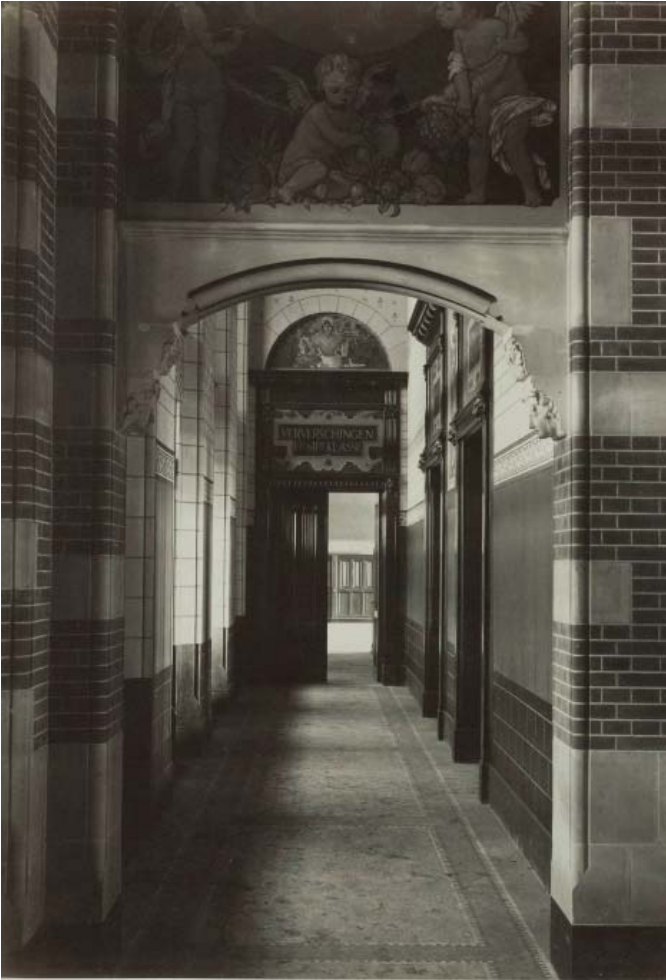
(afb. 100) zicht op de toegang van de restauratie, links is de overgang te zien van schoon metselwerk naar geschilderd metselwerk / foto 1889 SWM
