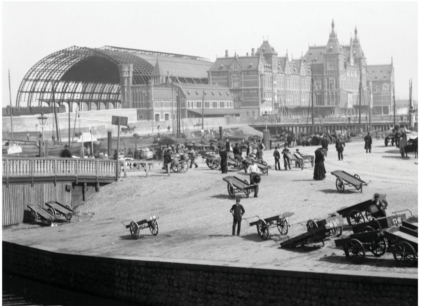
(afb. 228) zicht op het stationsgebouw en de spoorkap inbouw / foto 1889 GAA
