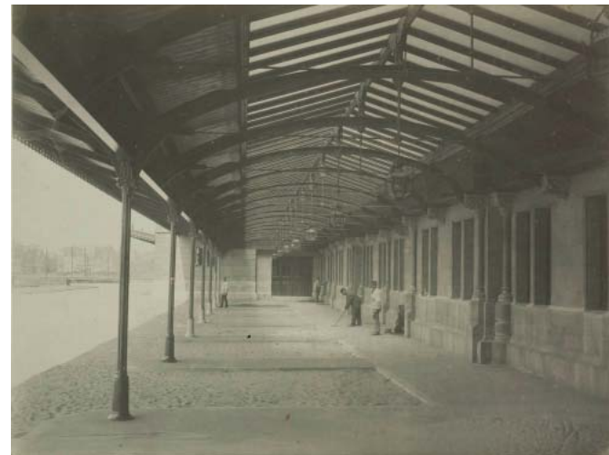
(afb. 119) zicht onder de luifel waar de repeterende constructie het beeld bepaald / foto 1889 SWM
