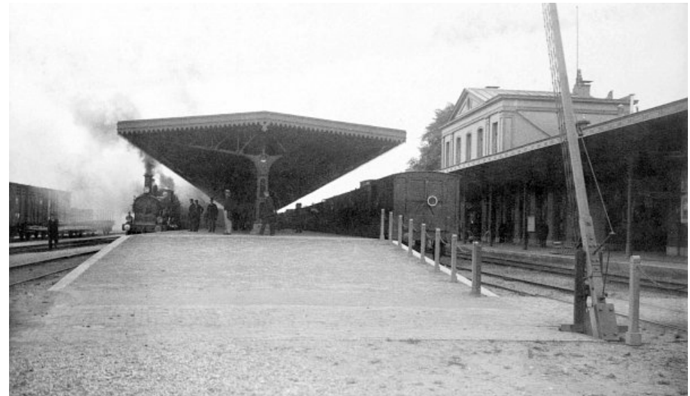
26. Rond 1900 werd het aantal sporen uitgebreid en het middenperron kreeg een dienst/wachtgebouw en een royale overkapping om de reizigers te beschutten., foto 1910. [Oud-Meppel]
