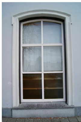
43d. Boven alle deur- en vensteropeningen op zowel de begane grond als de eerste verdieping zijn segmentbogen toegepast.
