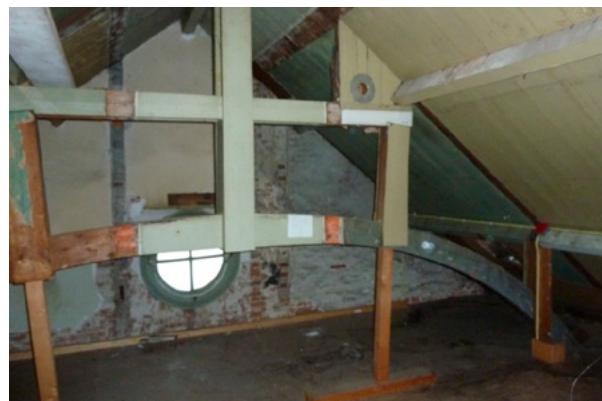
43e. De kapconstructie met het ronde venster in de voorgevel.
