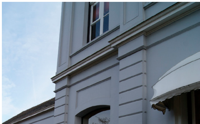
43a. De hoeken van de verschillende bouwdelen worden benadrukt door imitatie-rustica waarmee natuursteen wordt gesuggereerd.
