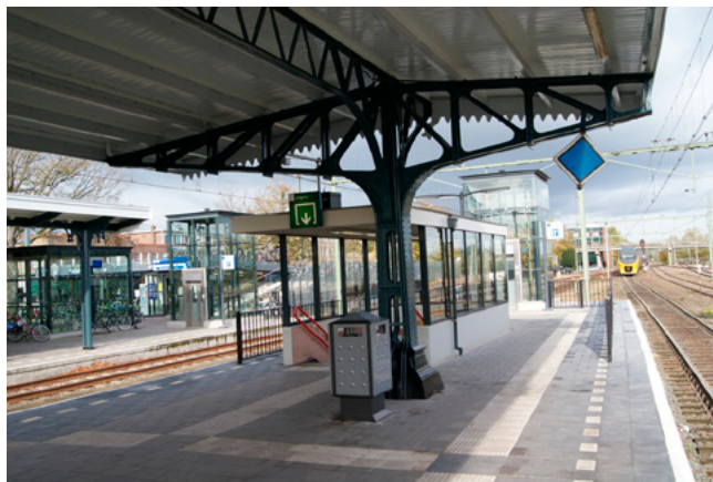
55. Originele perronkap op het middenperron, met geschulpte dakrand.
