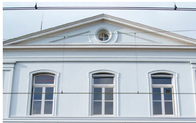
43b. Het risalerende middendeel is versierd met kroonlijsten en pilasters en wordt bekroond door een fronton met een rond venster.
