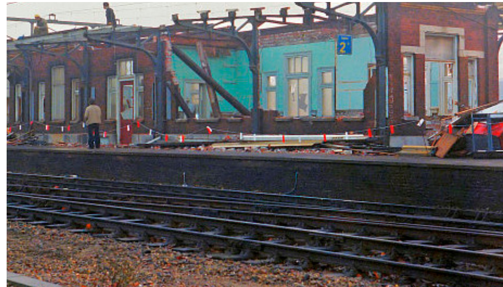
48. Sloop van het dienstgebouw op het middenperron, 1980. [Stationsweb]
