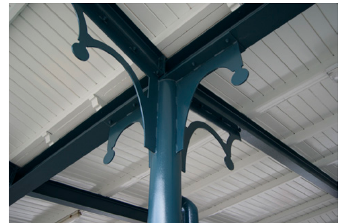
57. Consoles in het nieuwe deel van de perronkap, gebaseerd op de consoles van het oude deel.
