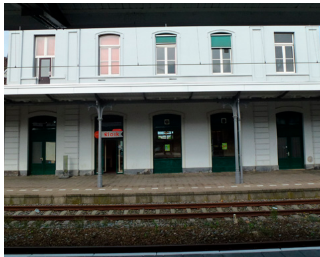
44. Deuren en ramen zijn vernieuwd, maar de vorm en de geprofileerde deuren- en vensterlijsten zijn intact, waardoor het historisch beeld overeind is gebleven.
