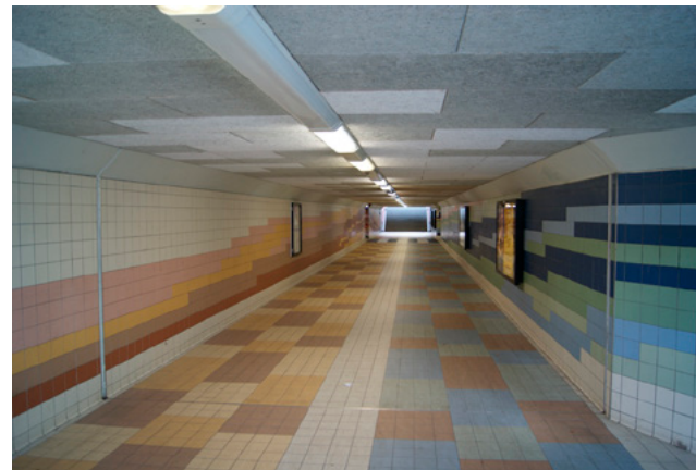
39. De verlengde spoortunnel die de achterzijde van het station ontsluit.
