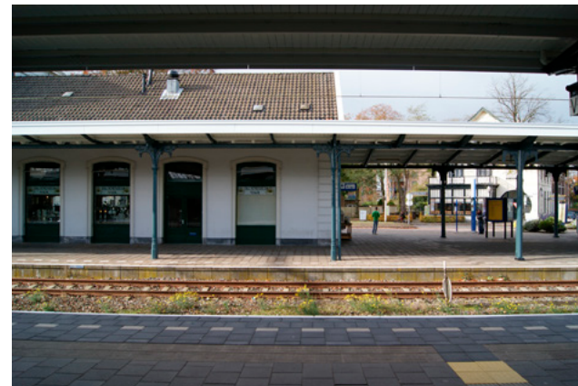
12. . Op de plek waar voorheen een kopgebouw stond (rechts) werd de perronkap aan de spoorzijde naar de tunnel doorgetrokken (zie ook afbeelding 14).
