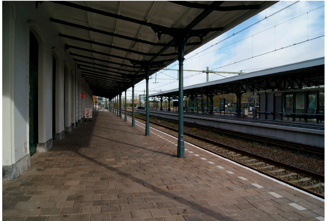
54. Originele perronkap aan gebouw.
