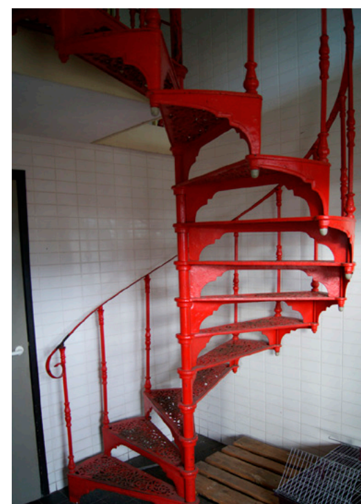
47. Wenteltrap naar tussenverdieping, geplaatst bij verbouwing in 1983.
