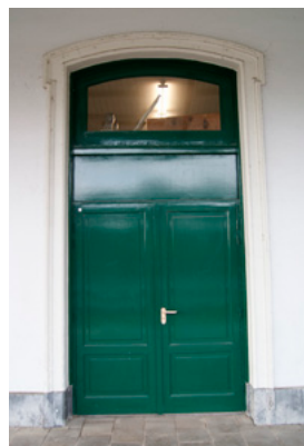
43d. Boven alle deur- en vensteropeningen op zowel de begane grond als de eerste verdieping zijn segmentbogen toegepast.
