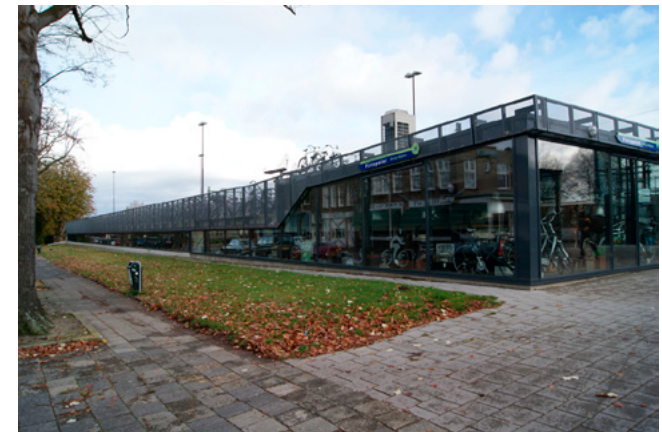
40. Recent opgeleverde fietsenstalling naast de reizigerstunnel.
