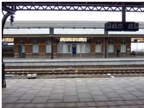
De twee oorspronkelijke wachthuisjes van Peters op perron 2 zijn later gekoppeld door een middendeel.
