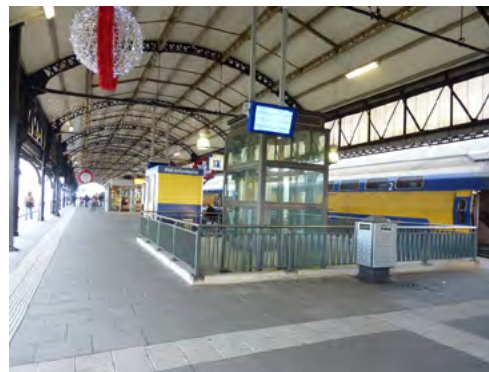
Nieuwe lift en trappartij.
