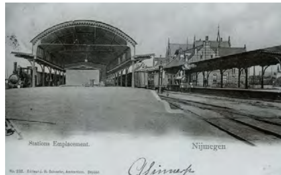
1904, de overkapping van perron 2. [SW]
