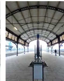
2011, oorspronkelijke constructie overkapping perron 2.
