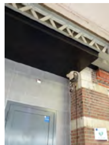
Aanhechting perronkap met de perrongevel en uitbouw.
