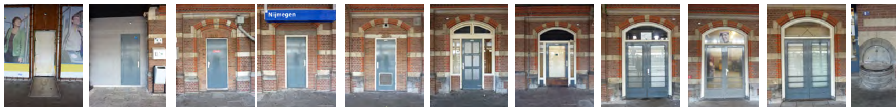
Enkele openingen in de perrongevel anno 2011
