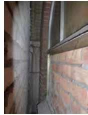
Dichtgemetselde bogen conserveren.
