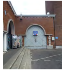
Dichtgemetselde bogen exterieur in het zicht laten komen of restaureren. [RAN]
