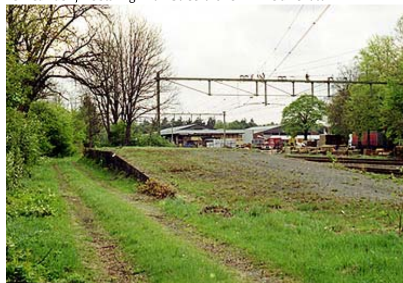
Oude los- en laadperron aan de noordoostzijde van het emplacement, gezien in oostelijke richting. Deze delen werden in 2008 gesloopt om plaats te maken voor het P+R terrein. Bron: artikel over Zuiderzeetram op www.oldebroek.net
