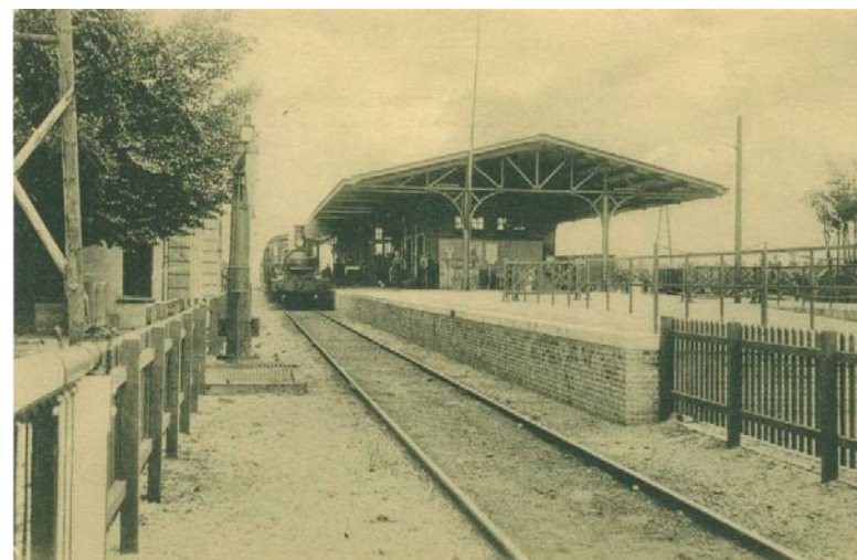
De trein richting Utrecht staat bij het station Nunspeet, omstreeks 1910. Links achter de boom is het oude stationsgebouw zichtbaar, met daarvoor de draibare vulkraan voor de stoomlocomotieven. Op de voorgrond de houten hekwerken die de oversteek naar het eilandperron afsluiten. Bron: Streekarchivaat Noord-West Veluwe, fotonr. 6986.
