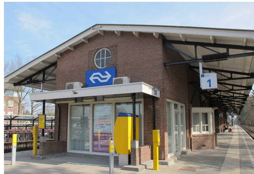
Zicht op het westelijke gebouw vanuit het zuidwesten.
