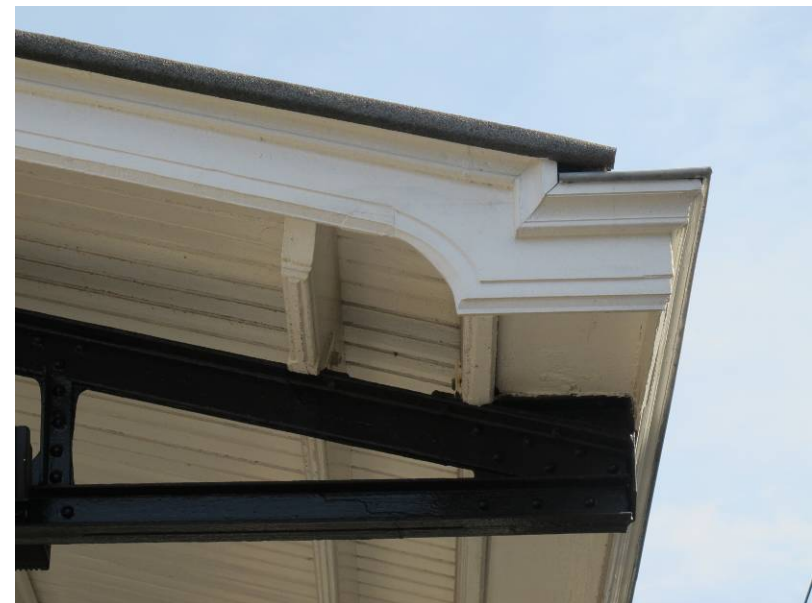
Detail van de verzorgd geprofileerde dakopbouw van de perronoverkapping.
