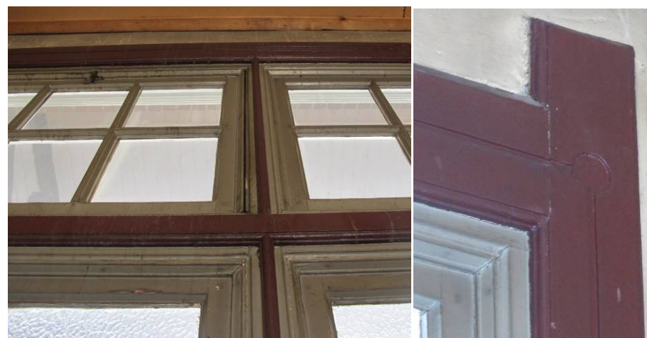
Oorspronkelijk venster in de westelijke opslagruimte en een detail van de vensteromlijsting.
