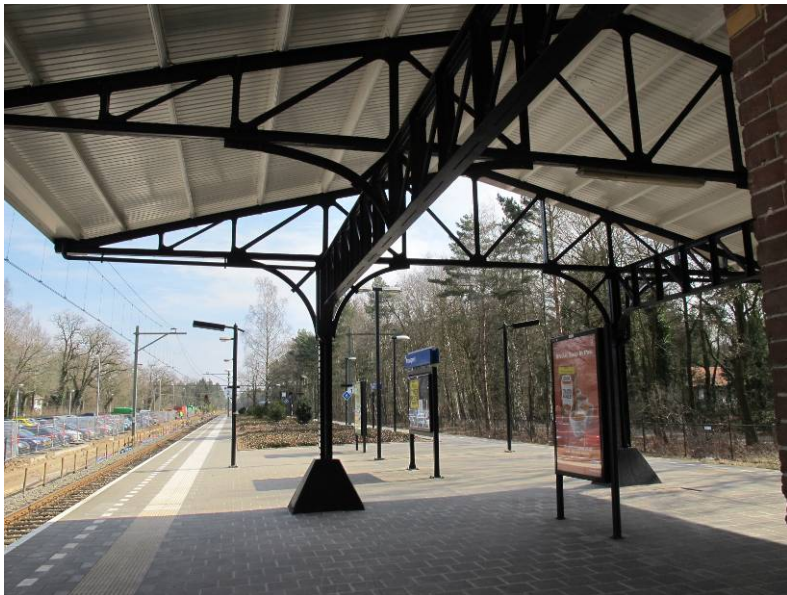
Aan de oostzijde steekt de perronoverkapping nog voorbij de gebouwen. Rond de onderzijde van de oorspronkelijke kolommen werd een betonnen voet gestort.
