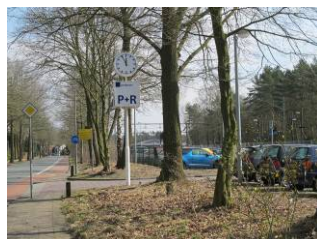
Aanleg P+R terrein
