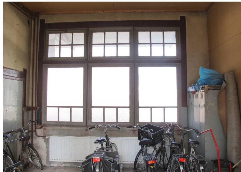
Westelijke opslagruimte met een oorspronkelijk venster en paneel in de westwand.
