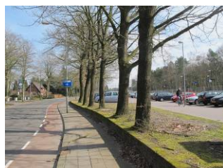
Aanleg keermuur en bomenrij langs F.A. Molijnlaan
