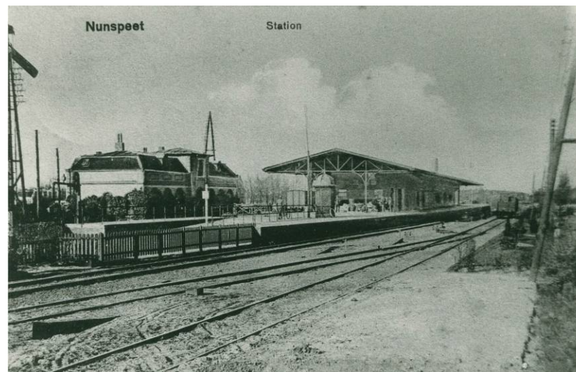
Het oude (links) en nieuwe station (rechts) in 1908, gezien vanuit het zuidwesten. Bron: Streekarchivaat Noord-west Veluwe, fotonr. 6554
