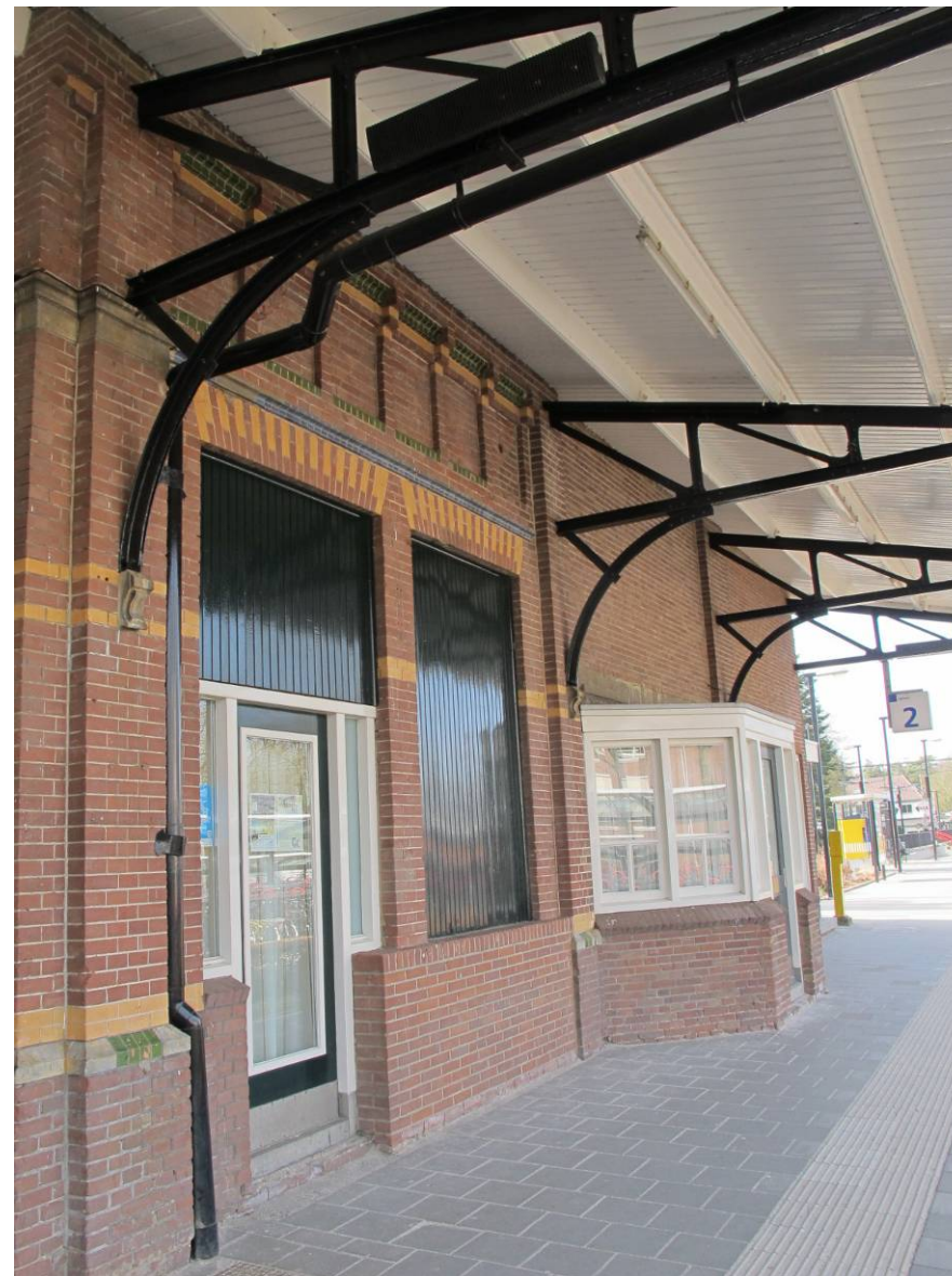
De noordgevel van het westelijke gebouw. De erker en de aan de gekleurde glazuurstenen herkenbare delen van het metselwerk zijn hier nog oorspronkelijk.
