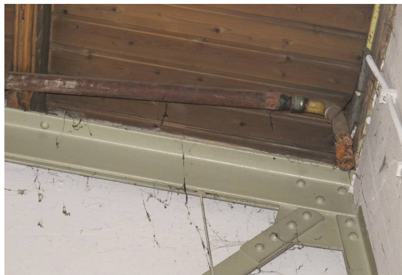
Plafond met geprofileerde balken van de dakconstructie in de CV-ruimte
