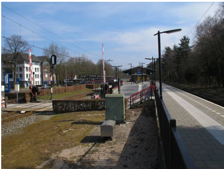
Het westelijke deel van het eiland perron, gezien in oostelijke richting. Links de overweg die de enige toegang tot het eilandperron vormt.
