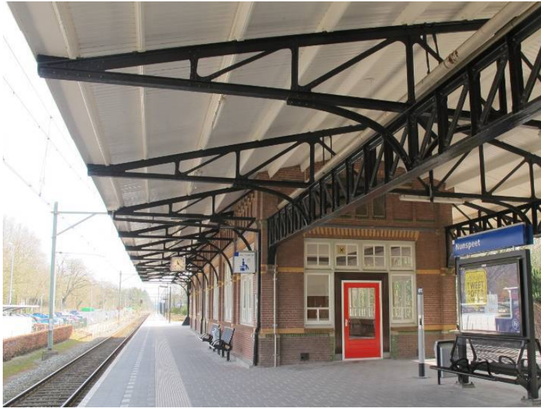
Overzicht van de constructie in het gebied tussen de twee stationsgebouwen.
