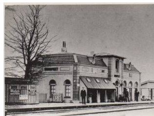
Sloop oude stationsgebouw
