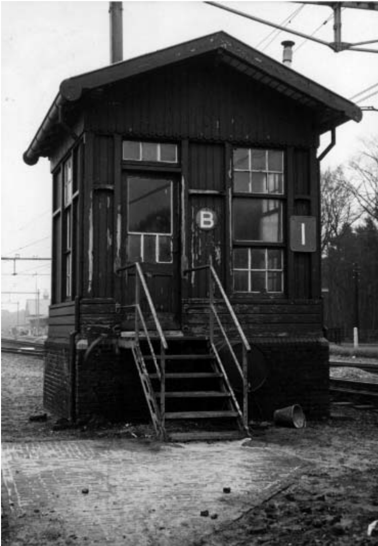
Dit seinhuis Post I stond bij station Nunspeet, waarschijnlijk direct ten oosten van het perron. Deze foto werd gemaakt in 1966. Bron: HUA, Collectie NS, catalogusnr. 154731
