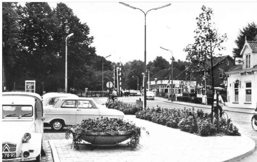
Zicht vanaf het Stationsplein richting de overweg in de Elspeterweg in de jaren '70. Door de kleinschalige bebouwing heeft het gebied dan nog een 'dorpse' sfeer. bron: http://albertymara.wordpress.com/category/spoorwegstations/
