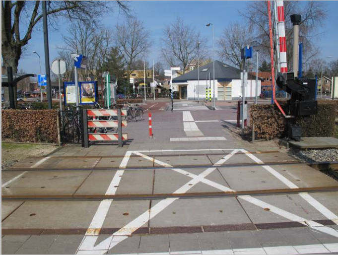
Onoverzichtelijke aansluiting op aansluitend openbaar vervoer via gevaarlijke oversteek F.A. Molijnlaan
