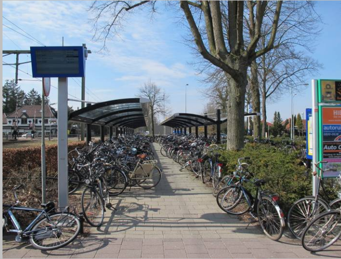
Buiten vakken gestalde fietsen belemmeren toegankelijkheid
