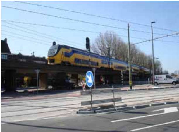
Het spoorviaduct in Delft
