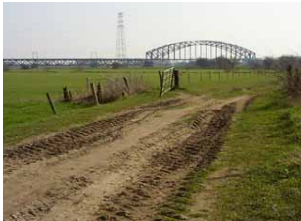
De spoorbrug bij Oosterbeek over de Nederrijn.
