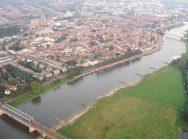
Spoorbrug over de IJssel bij Deventer
