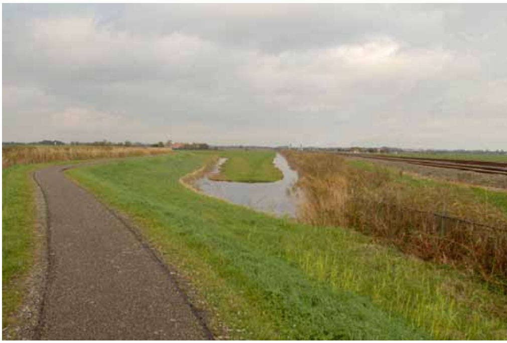
Het effect van een bovenleiding is groot. Zo heeft de lijn Zaandam-Purmerend er vijftig jaar geleden waarschijnlijk uitgezien (fotomontage)
