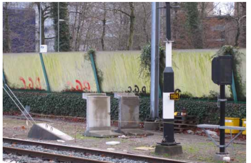
Goed onderhoud is daarbij onontbeerlijk (station Dordrecht).
