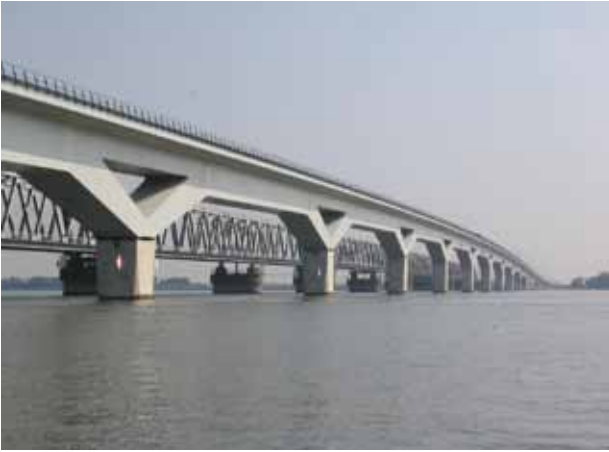
De twee Moerdijkbruggen (HSL en gewoon) over het Hollandsch Diep.
