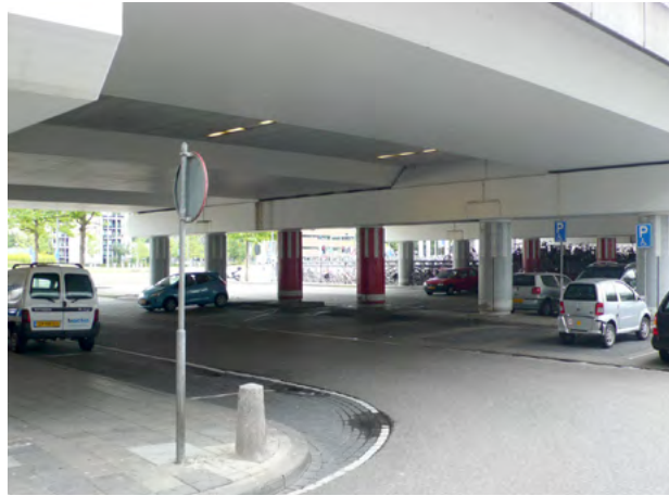
Lusvormige ontsluiting onder het viaduct.
