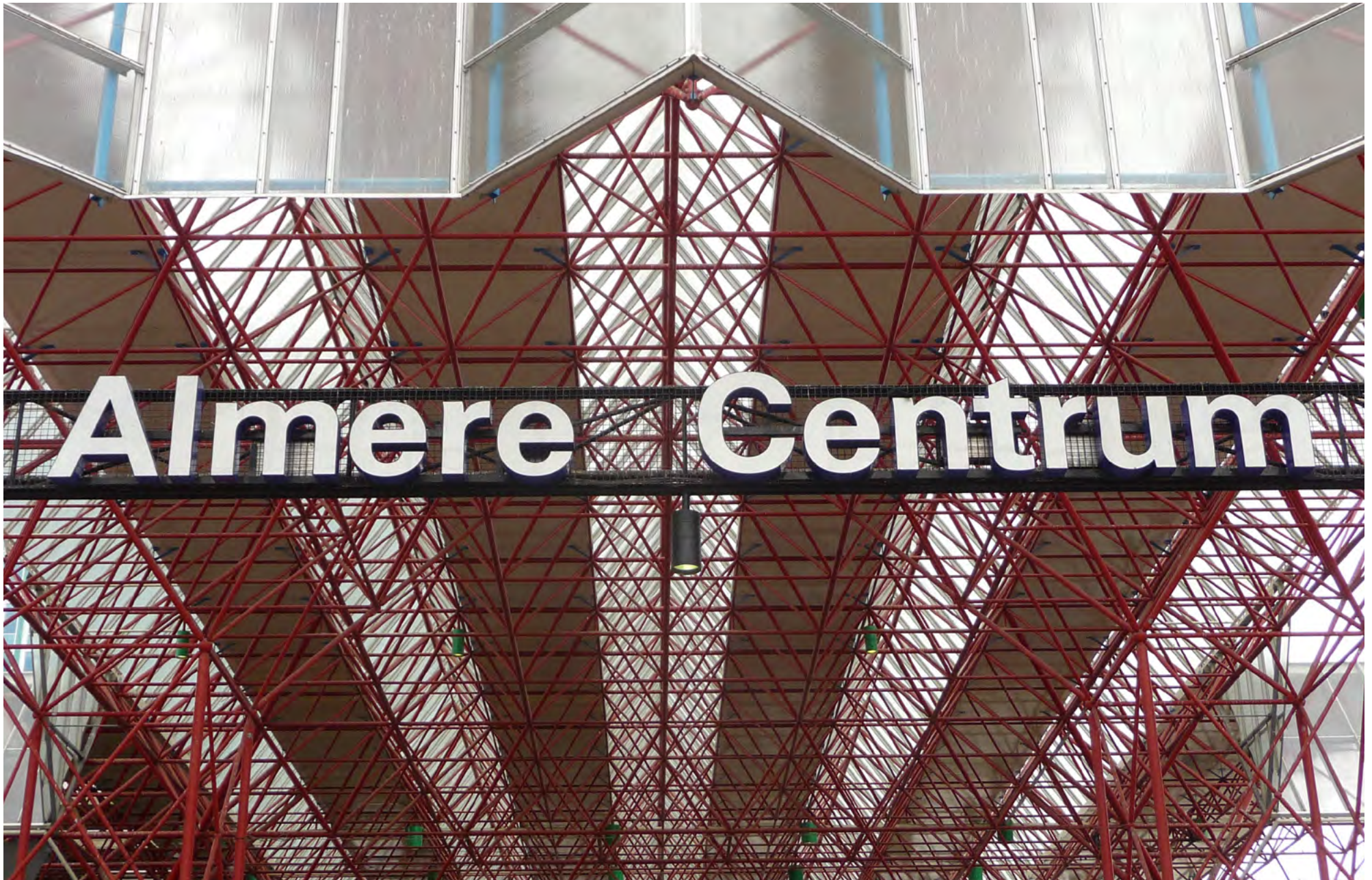
Het rode ruimtevakwerk met luifel en glazen kopstukken als beeldbepalend element van het station.
