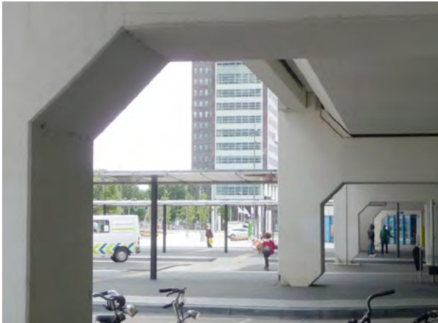
Betonnen onderslagbalken met afgeschuinde hoeken.
