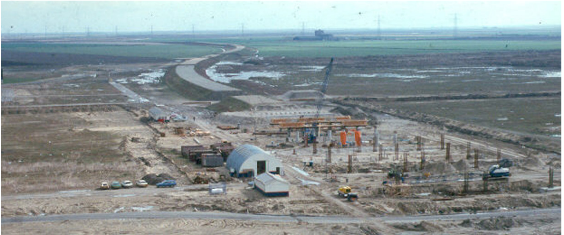
Spoordijk en viaduct in aanleg in 1983. Bron: flevolandbovenwater.nl.
