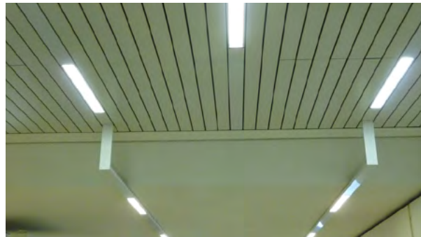
Plafond met vernieuwde armaturen.
