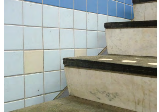
Detail in het trappenhuis.
