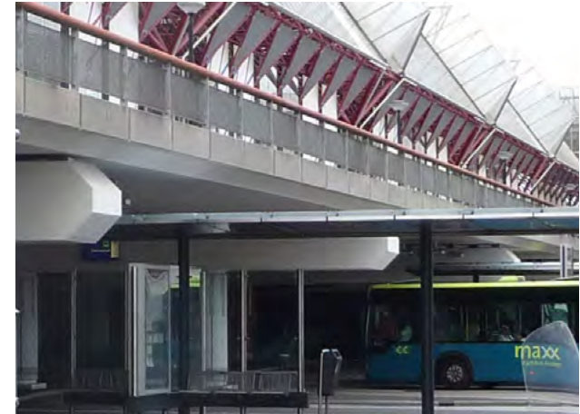
Uitragende onderslagbalk waarop het verhoogde Spoorbaanpad rust, een kruisingsvrij pad voor fietsers.
