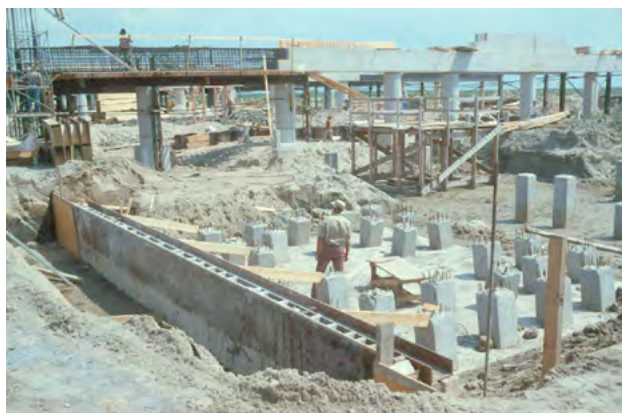
Bouw van het viaduct in 1983. Bron: flevolandbovenwater.nl.
