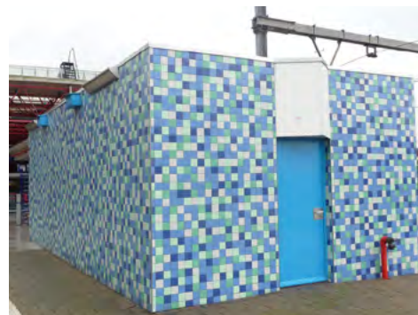
In 2009 vernieuwde muurtegels dienstgebouw.
