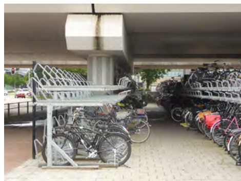
Rond 2010 gerealiseerde fietsenstalling op de voormalige parkeerplaats.
