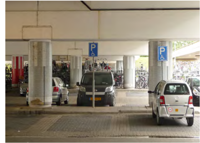
Parkeren onder het viaduct.
