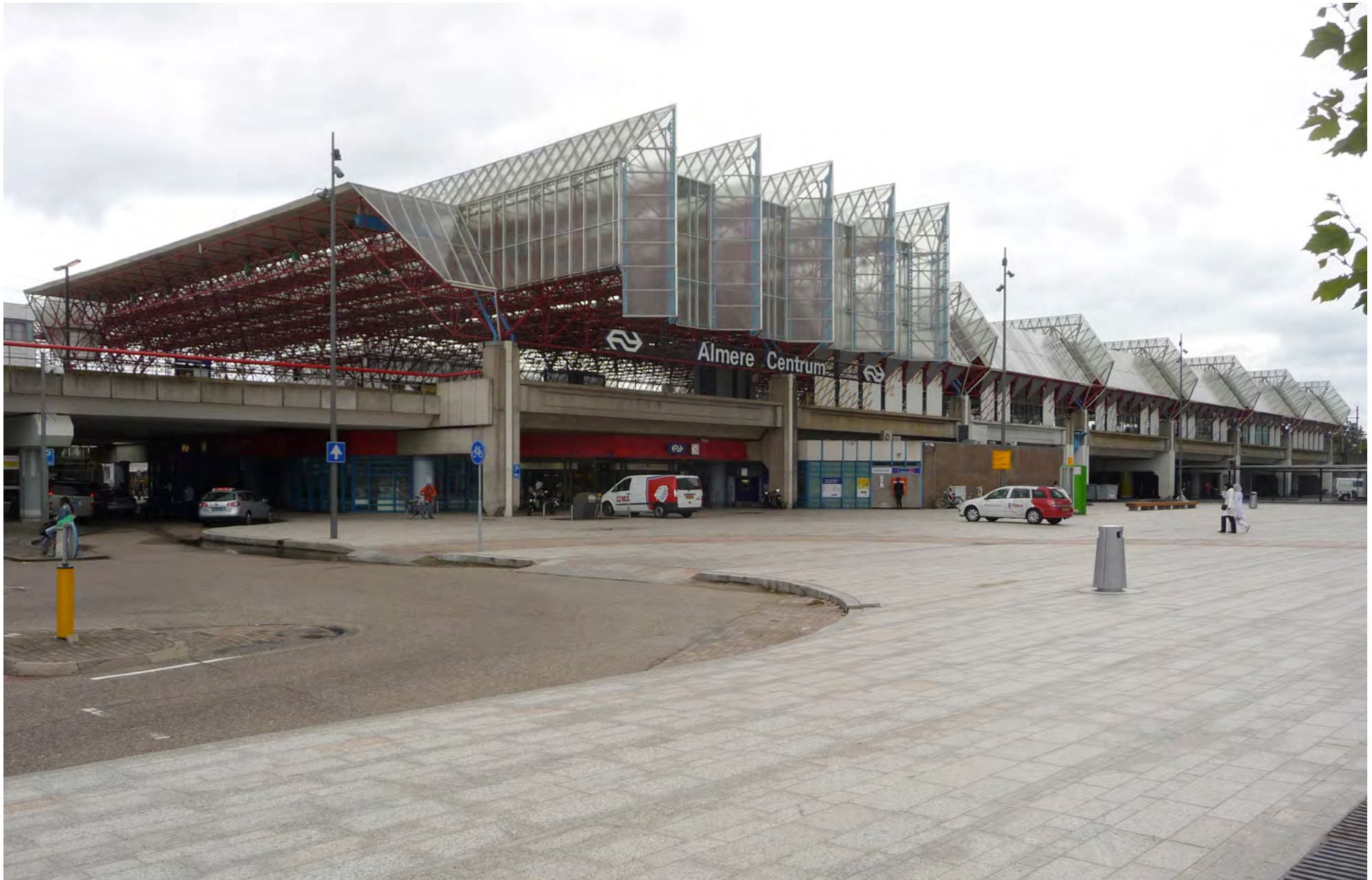
Het viaduct met station gezien vanaf het Mandelaplein.
