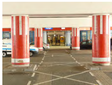
Rode kolommen in de lengterichting op de parkeerplaats.
