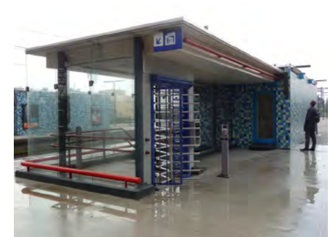
Dienstgebouw met opgang boven fietsenstalling.
