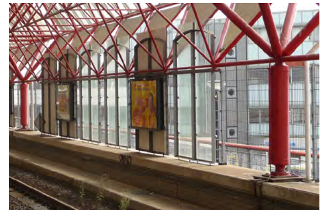
De overkapping steunt op betonnen kolommen en pijlers en stalen kolommen.
