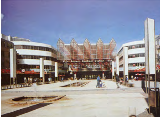
Stationsplein richting station. Bron: Bouw (1989) 13.
