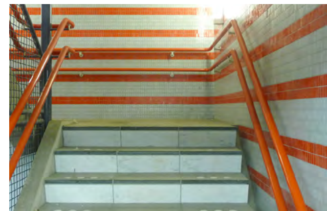
Eén van de twee trappenhuizen in de fietsenstalling.
