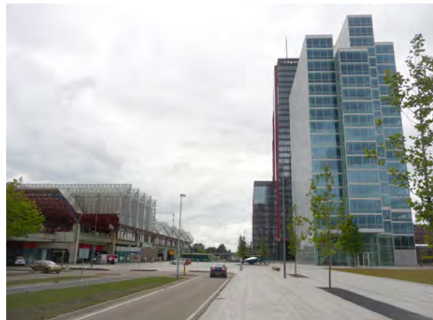
Zakencentrum WTC ten noorden van het station in ontwikkeling.
