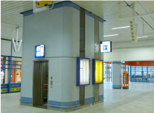
Liftschacht met venstersleuven in de zijwand.
