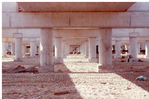
Bouw van het viaduct in 1984. Bron: flevolandbovenwater.nl.
