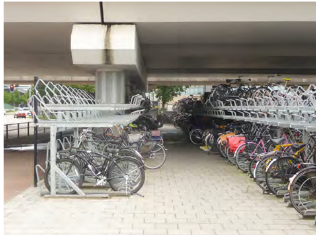
Rond 2010 gerealiseerde fietsenstalling onder het viaduct.
