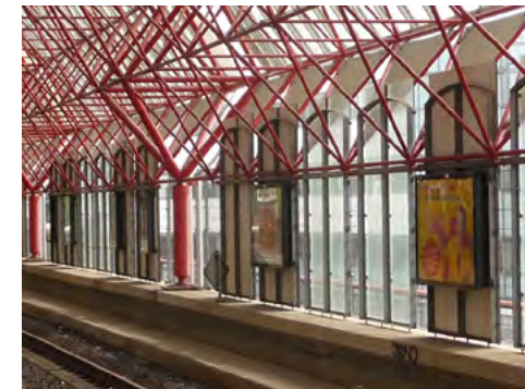
Reclameborden tegen de buitenwanden.
