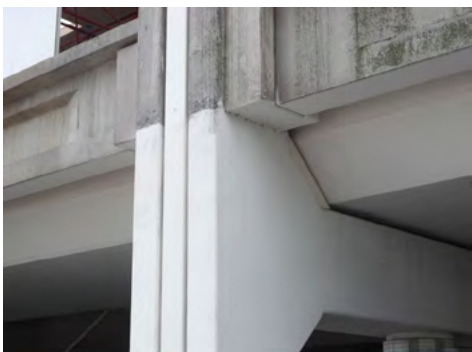
De gedeeltelijk geschilderde betonconstructie.
