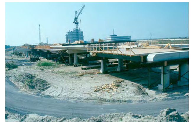
Bouw van het viaduct in 1984. Bron: flevolandbovenwater.nl.
