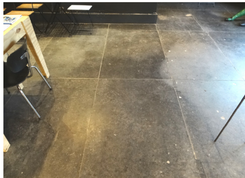
Afb. 5.22 De originele hardstenen vloer in de vestibule. Rechtmidden zijn smalle aanvulstroken zichtbaar, die de locatie van de vroegere scheidingsmuur aangeven.
