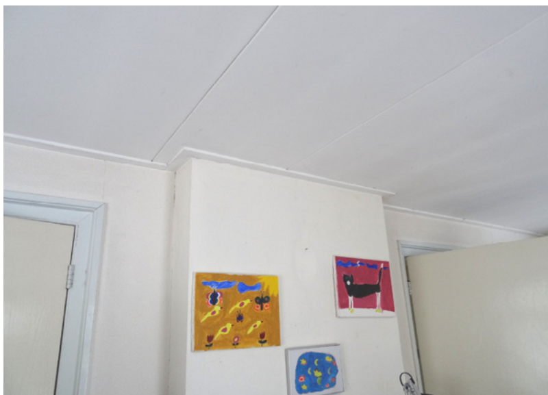
Afb. 5.27 Het gipsplaatplafond in de bovenwoning. Links en rechts van de schouw zijn delen van de board-deuren zichtbaar, met originele kozijnen.
