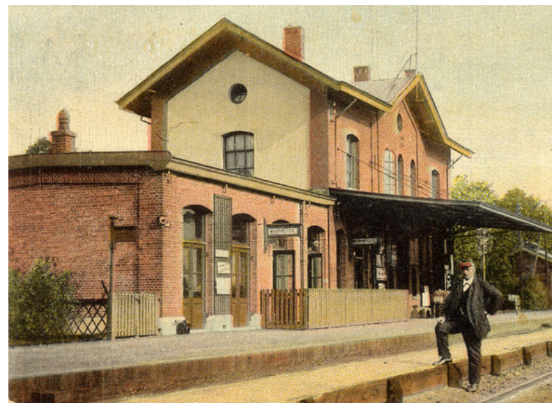
Afb. 5.4 Het wit gestucte muurvlak, binnen de omlijsting van metselwerk aan de westgevel van Delden. Detail van ingekleurde Ansichtkaart, circa 1920, coll. Twents Streekarchief.
