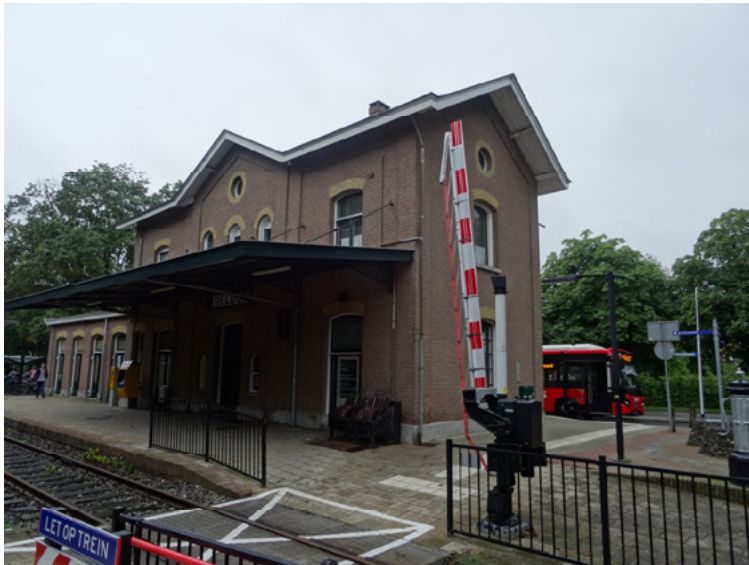
Afb. 4.17 Het lage, vroegere perron aan de spoorzijde van het gebouw. Over de breedte van het hoofdvolume is het perron overkapt met de originele perronkap.
