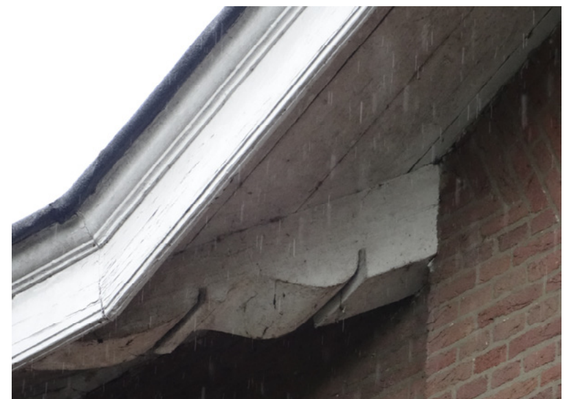
Afb. 5.15 Geornamenteerde houten drager onder de overstek.
