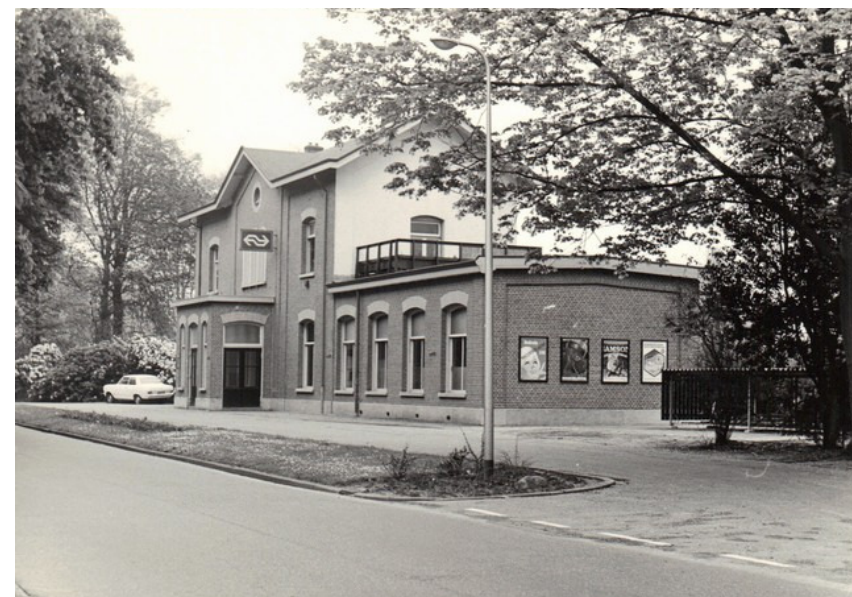
Afb. 2.11 Het station met balkon op de vleugel en witgeschilderde kozijnen. Foto 1978, coll.
