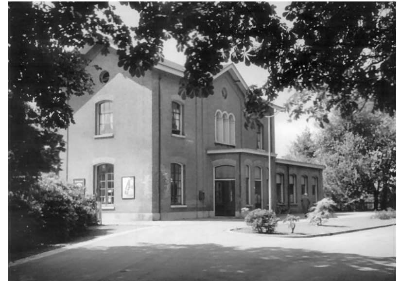
Afb. 4.10 De straatzijde van het station, met de voorrijstrook. Foto 1970.
