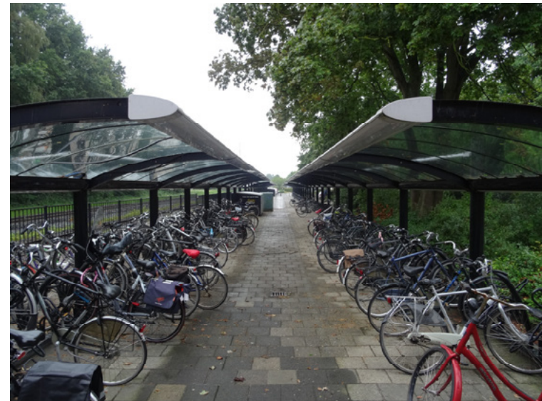
Afb. 4.19 De fietsenstallingen ten westen van het station.
