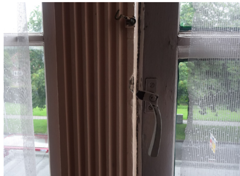
Afb. 5.28 De originele sluitwerk aan de halfronde ramen aan de straatzijde .
