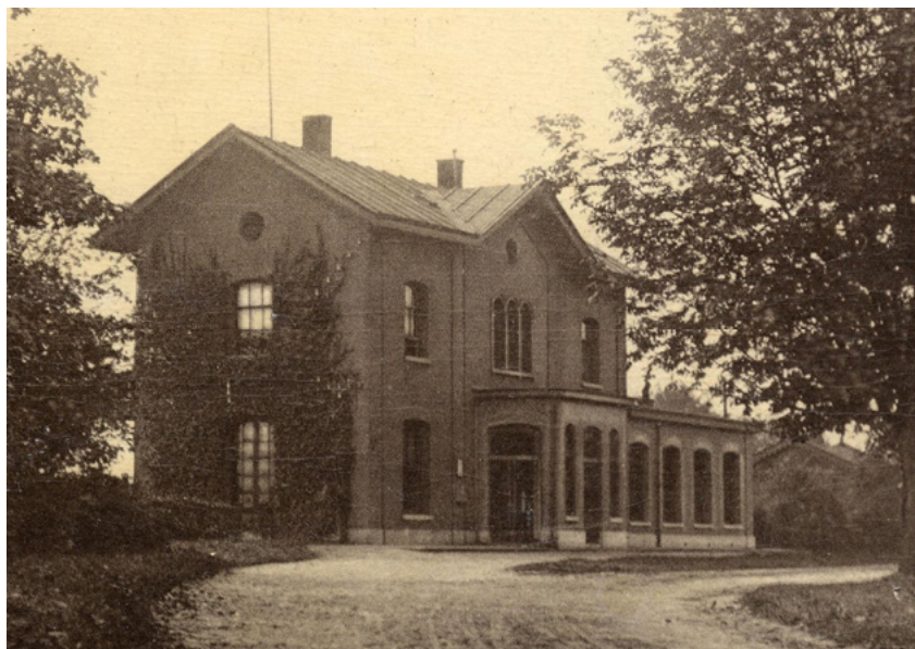
Afb. 2.7 Het uitgebreide station met tochtportaal en vleugel. Detail van foto uit circa 1906, coll. Twents Streekarchief.
