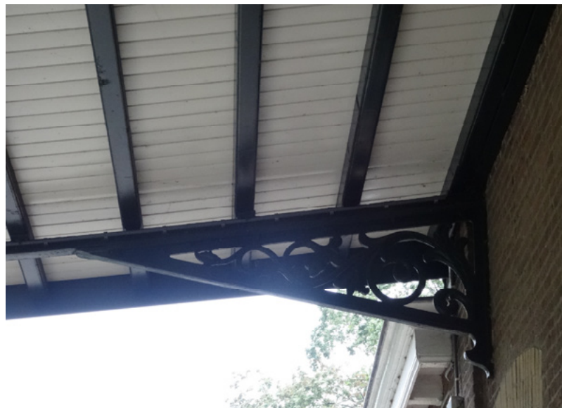
Afb. 5.19 De geornamenteerde gietijzeren korbelen onder de draagbalken.
