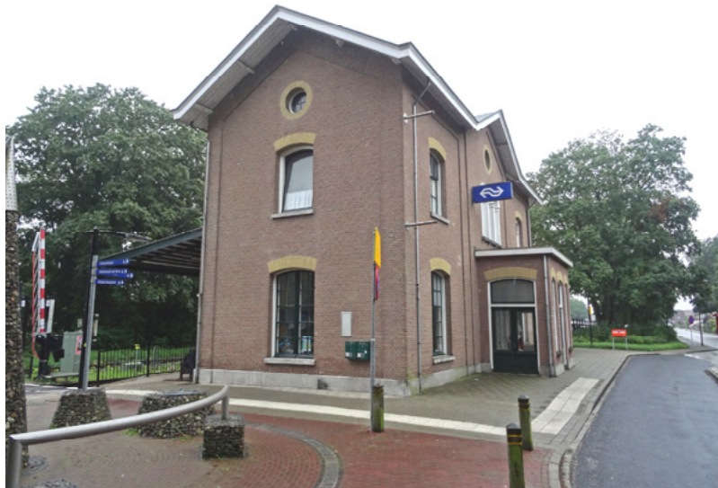
Afb. 5.12 De oost- en noordgevel van het stationsgebouw.
