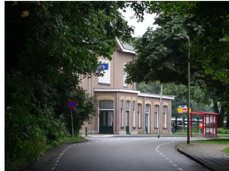
Afb. 3.4 (1) Het station in de bocht van de Stationsweg, gezien vanuit het oosten. Door het vele omringende groen, heeft het station de uitstraling van landelijke ligging behouden.
