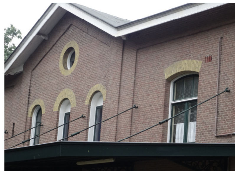
Afb. 5.17 De drie gescheiden ramen, centraal in de achtergevel. Twee van de drie ramen hebben geen bovenlicht meer. Tussen de ramen zijn de haken bevestigd voor de trekstangen van de perronkap.
