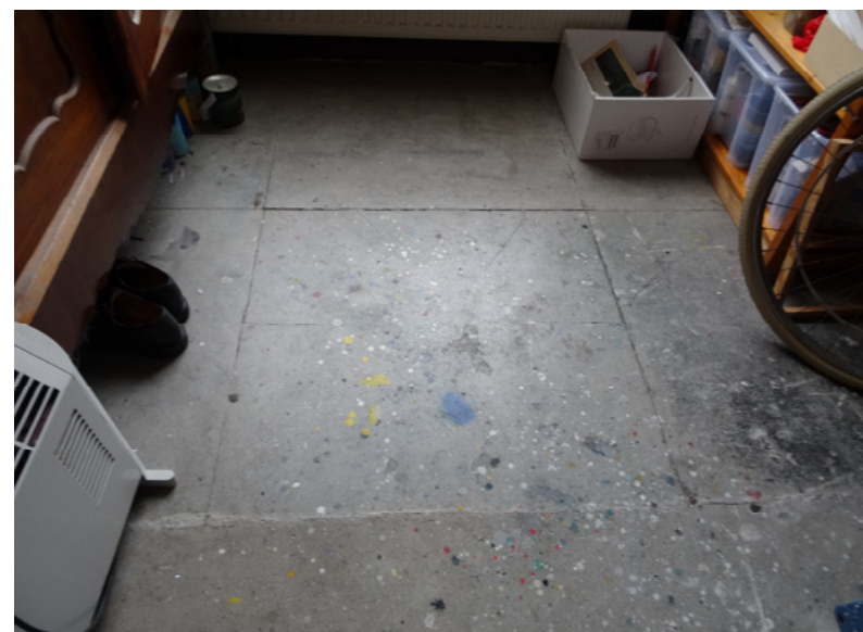
Afb. 5.23 De originele hardstenen vloer uit 1905 in het atelier. Op de voorgrond een betonnen rand die de vroegere scheidingsmuur markeert.
