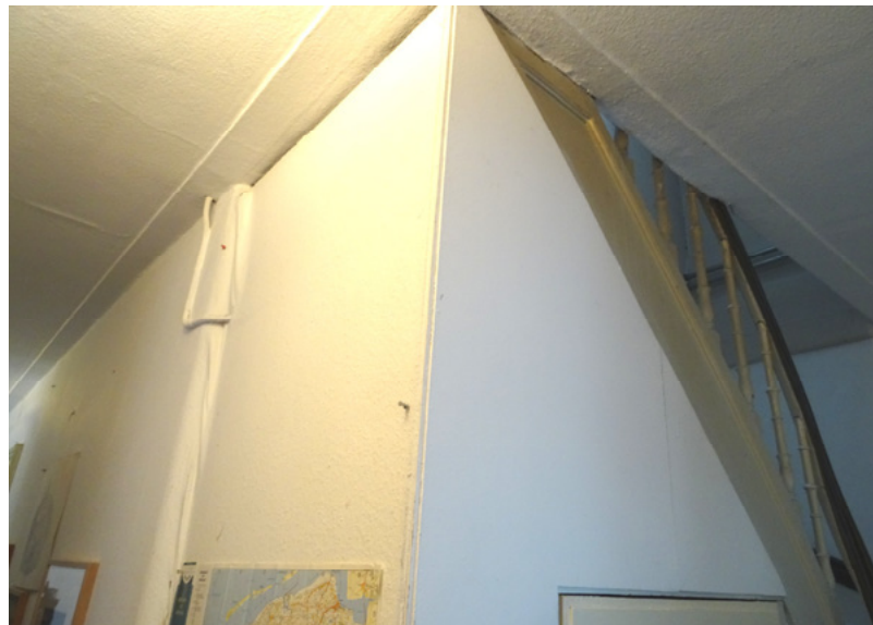
Afb. 5.26 De wanden van de bovenwoning zijn afgewerkt met structuurbehang. Rechtsboven de trap naar de zolder.
