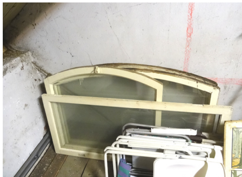
Afb. 5.29 Oude kozijnen, die na een verbouwing zijn bewaard op de zolder.
