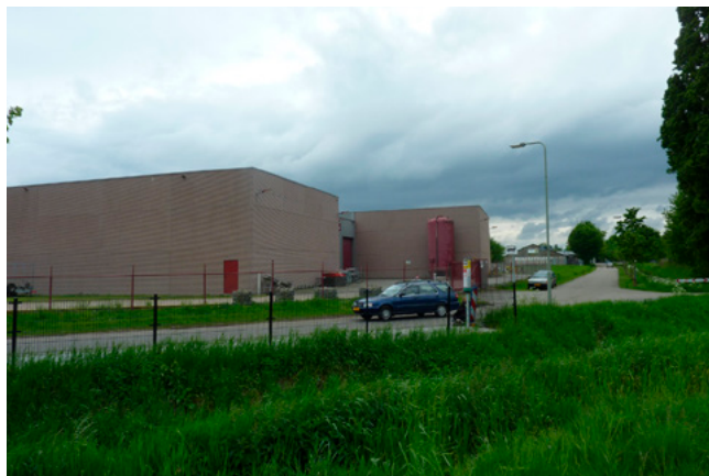
39. Bedrijfsloodsen aan zuidzijde ontnemen het open zicht op landschap.
