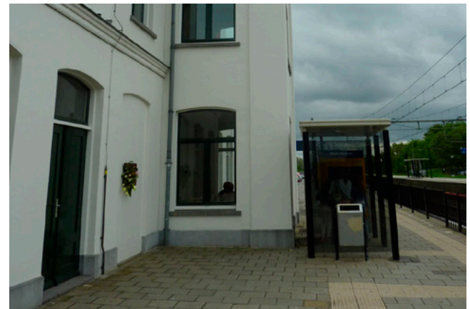
36. Kaartautomaat met afdak te dicht op gebouwen op smalste deel perron.
