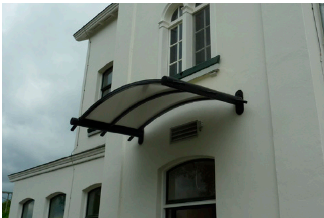
34. Luifel aan de voorzijde van het station (toevoeging 1992).
