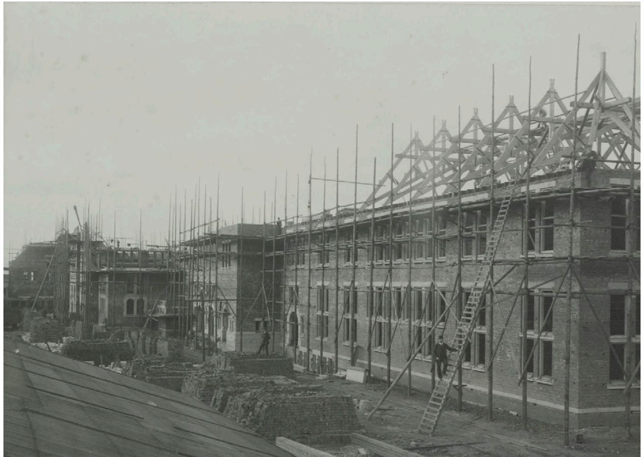
Bouw van het station, 1914. [GVN]
