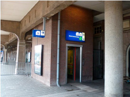
Lift van de voetgangersbrug in het langsperron.
