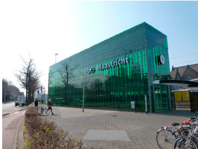
Ingang van het station aan de Meerssenerweg
