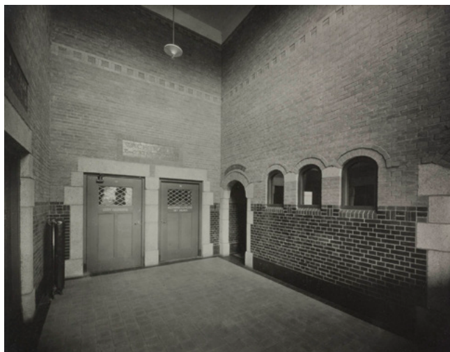
Portaal met toegang tot de wachtkamer 1ste/2de klasse vanaf het langsperron, 1915. Rechts is de toegang naar de toiletten. [GVN]
