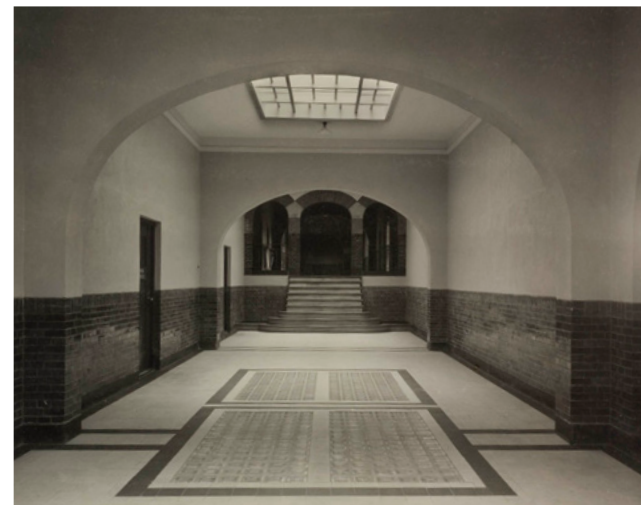
Personeelsgalerij op de eerste verdieping ter hoogte van de goederenruimte op de begane grond, 1915. Op de vloer zijn glazen bouwstenen opgenomen ten behoeve van de daglichttoetreding van de goederenruimte. [GVN]
