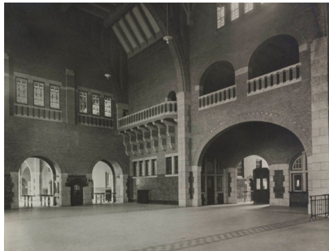
Stationshal met links op achtergrond de doorgang naar de hal en de wachtkamers. De doorgang rechts leidt naar het langsperron, 1915. [GVN]
