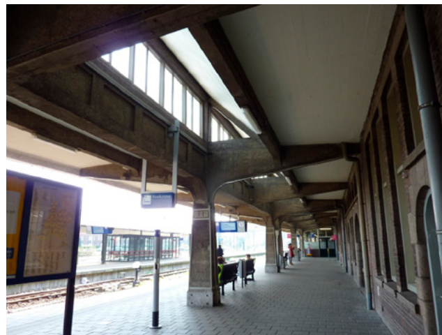
Sheddaken in de perronkap van het langsperron.
