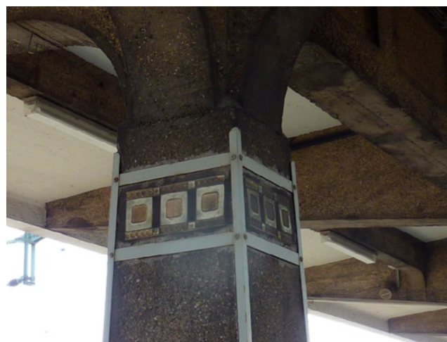
Detail van de betonnen kolom.
