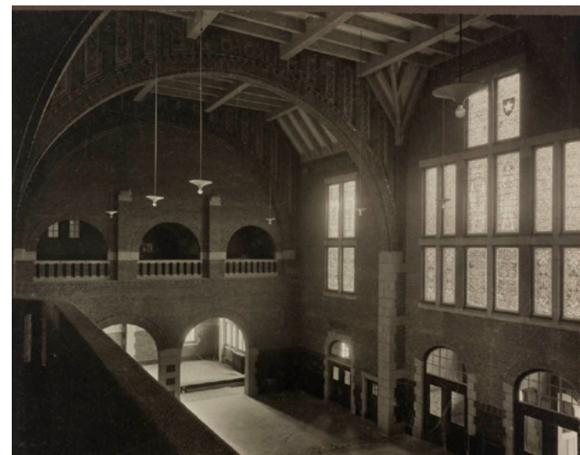
De vestibule gezien vanaf de personeelsgalerij, 1915. [GVN]
