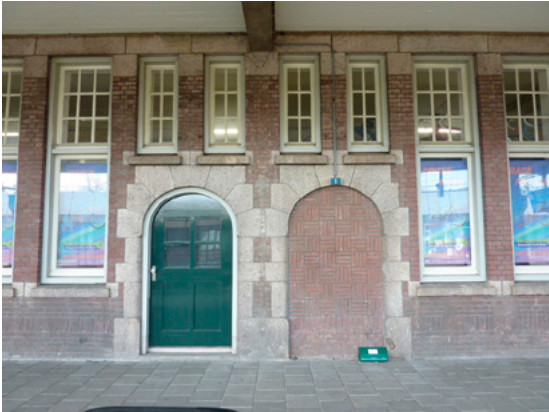
Perrongvel ter hoogte van de fietsenstalling. De doorgangen waren voorheen bedoeld voor de toegang naar de toiletten.
