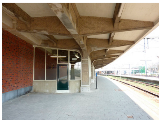
Uitbouw van de fietsenstalling in het langsperron.
