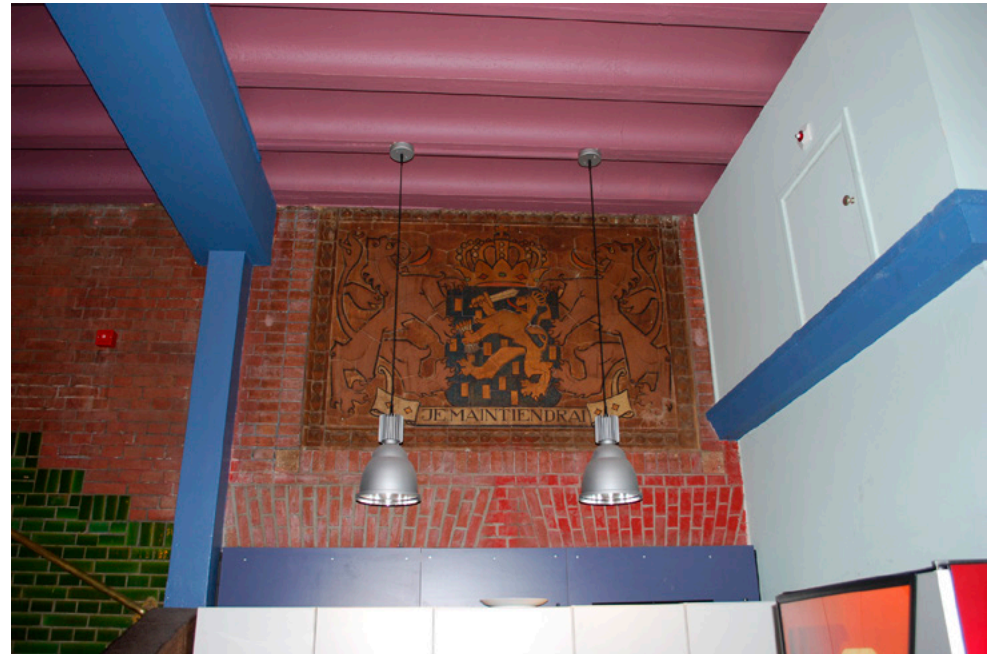
Origineel metselwerk, verglaasde baksteen en tegeltafel met wapen van Holland. Blauw en lila zijn de onderdelen van de niet-originele tussenverdieping. [J.Ruland]
