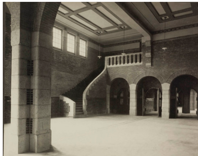
Hal met doorgang naar de koppersperrons., 1915. De trap geeft toegang tot de eerste verdieping (bergruimte boven hal en boven de restauratie wachtkamer 1ste en 2de klasse). [GVN]
