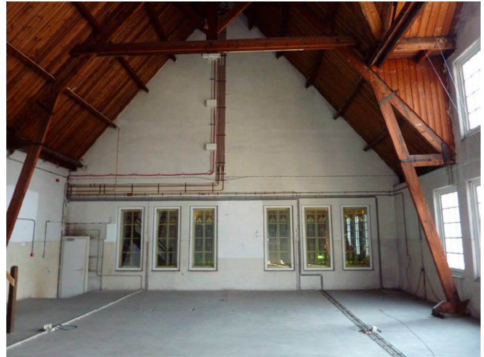
Zolderruimte eerste verdieping boven de hal.
