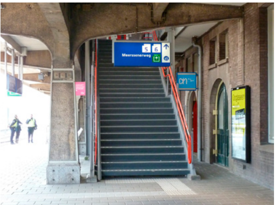
Trap naar de voetgangersbrug in het langsperron.
