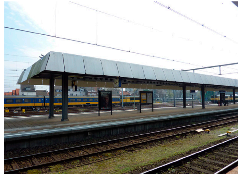
Perronoverkapping van het perroneiland (ontwerp C. Douma, 1985) aan de oostzijde van het stationsgebouw.
