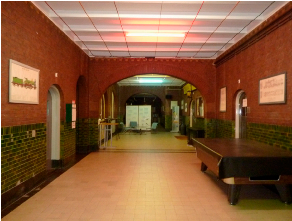
Personeelsgalerij op de eerste verdieping ter hoogte van de vestibule, met lambrisering van verglaasde baksteen.
