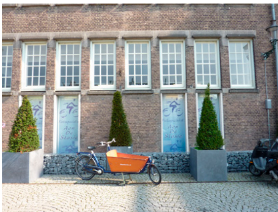
Verlengde vensteropeningen in de voorgevel ter hoogte van de fietsenstalling.
