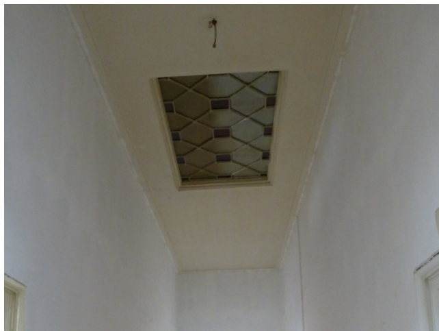
Overloop op de bovenverdieping met daklicht.
