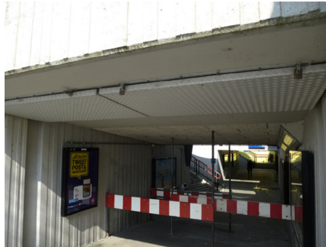
De voetgangerstunnel onder het spoor.
