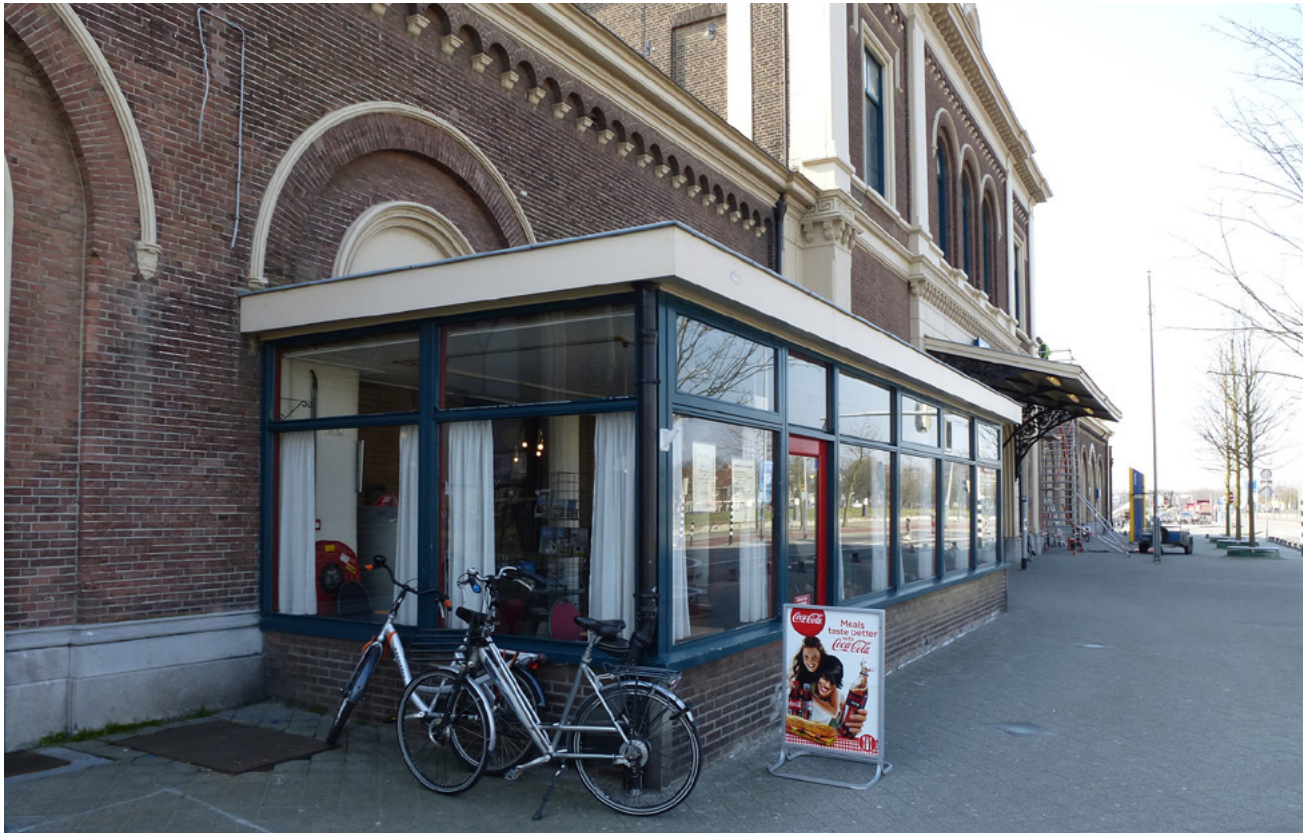
Aan de oostvleugel is aan de voorzijde een aanbouw geplaatst (rond 1920) in een afwijkende vormtaal. De uitbouw heeft veel invloed op het aanzicht van het hoofdgebouw. De meer zakelijke bouwstijl detoneert met de neoclassicistische bouwstijl van het hoofdgebouw en doorbreekt de symmetrie van de representatieve voorgevel.
