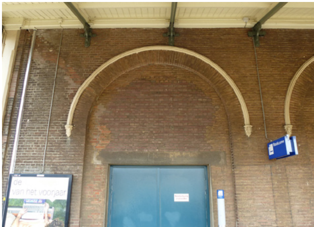
Slecht één rondbogvenster is deels dichtgemetseld en vervangen door een reguliere deur (geheel links in de achtergevel), de rest is nog intact.
