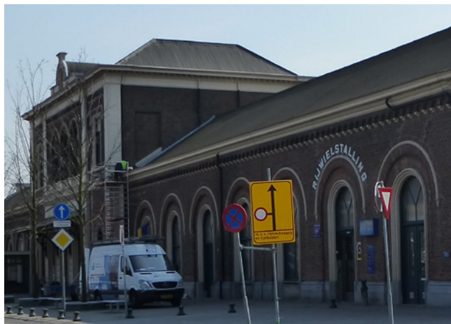
De dakvorm is intact. Op het hoofdgebouw ontbreken tegenwoordig de vier schoorstenen. De oorspronkelijke bedekking met leien is verdwenen, de daken zijn nu bekleed met bitumen.
