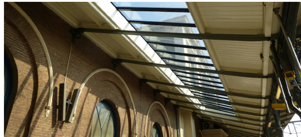
De daklichten in de luifel anno 2013, ten opzichte van 1909 is de positie gelijk maar de vorm veranderd, 2013.
