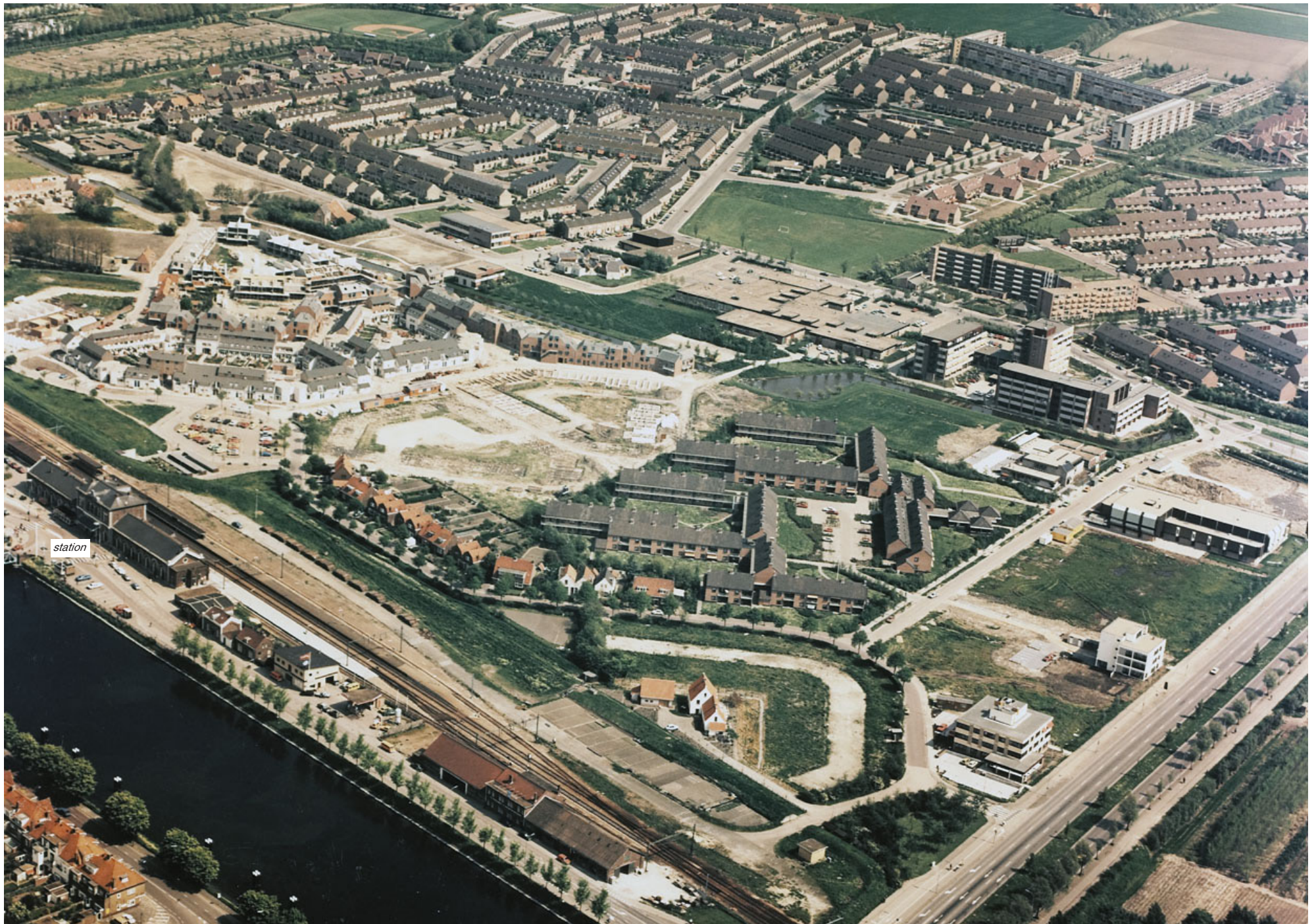
Nieuwe woonwijk in aanbouw achter het station, jaartal onbekend. [Zeeuws Archief]
