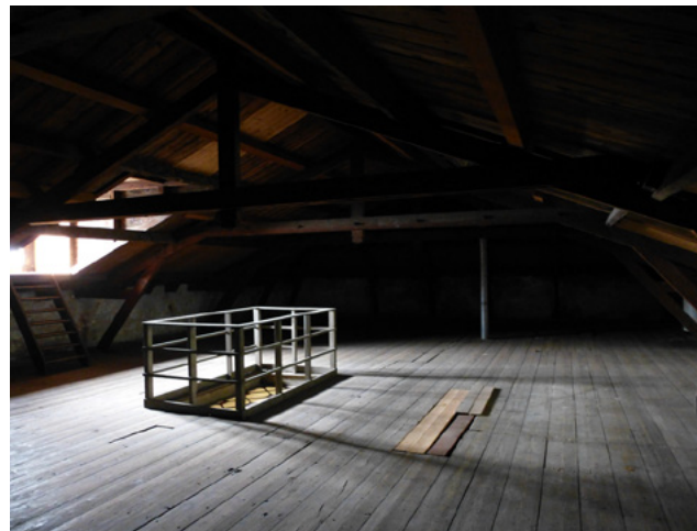
Daklicht op zolder met origineel glaswerk, ter verlichting van de overloop.
