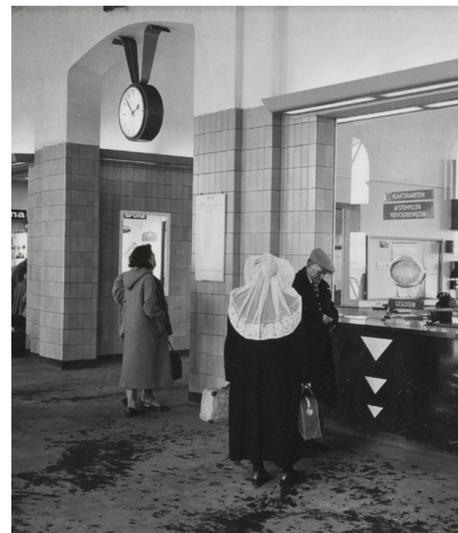
De indeling van de stationshal uit 1953: de doorgang naar het eerste perron, de afwerking met de lichte wandtegels en de stationsklok, foto uit 1956. [Spoorwegmuseum]
