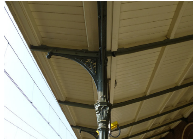
De perronoverkapping die is bevestigd aan de achtergevel (over het eerste perron) is origineel.
