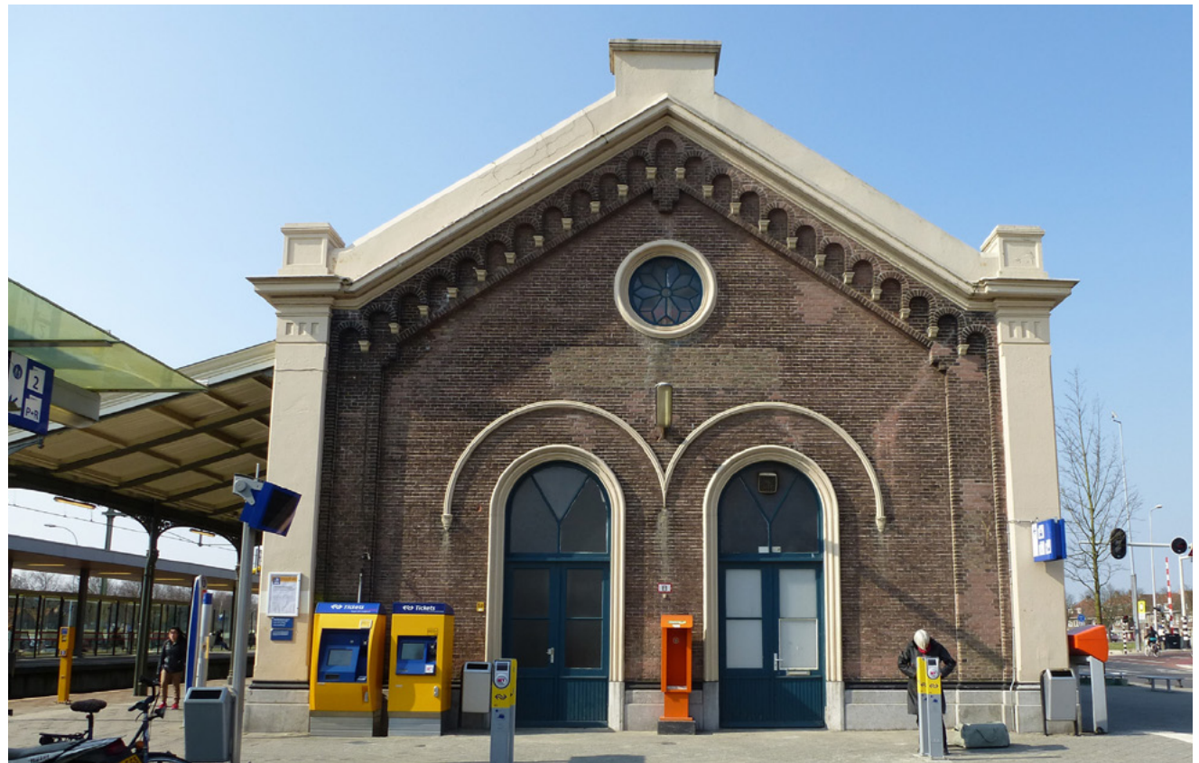
In de zijgevel van de oostvleugel zijn de kozijnen en de roede verdeling van beide deuren vervangen. Ook ontbreekt hier het bord met de stationsnaam.
