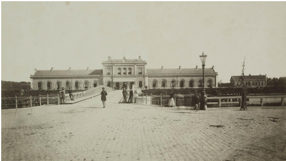
De standaardstations hebben een eenvoudige, langgerekte hoofdvorm, een symmetrische opzet, en een sobere vormtaal, station Middelburg in 1901. [Spoorwegmuseum]
