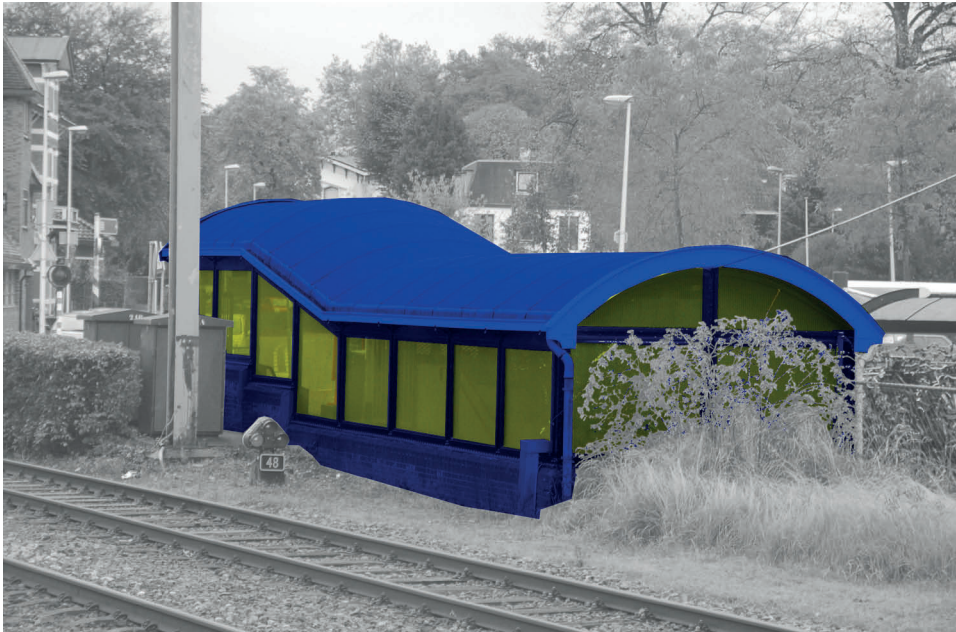
Waardering overkapping boven opgangen zuidelijke perrontunnel
