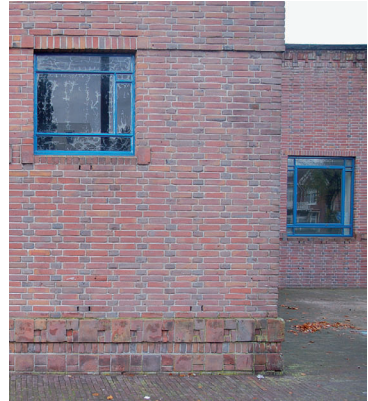
Originele stalen kozijnen
