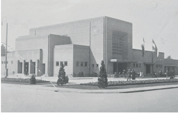
Station Naarden-Bussum (1926): Baksteen kubisme
