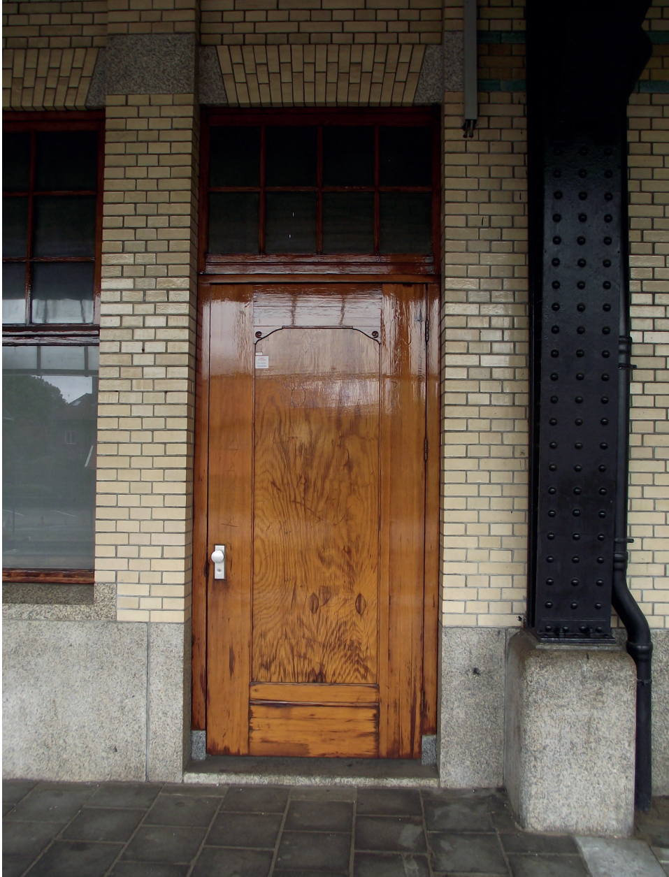
Originele deur in het zuidelijke perronegebouw
