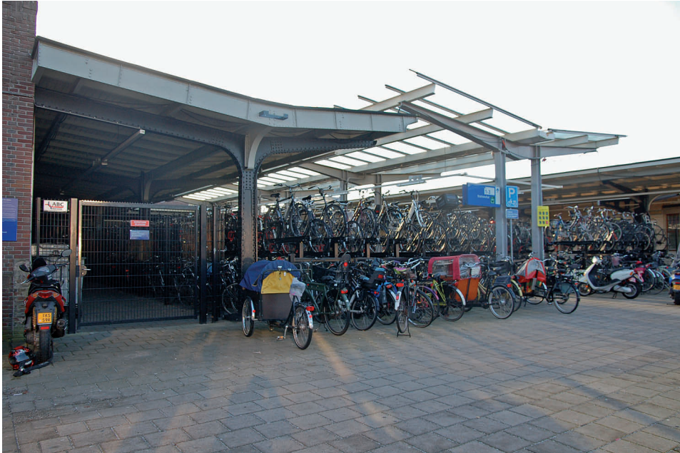
Perron-overkapping 'Gooische Tram Maatschappij'. Nu een fietsenstalling
